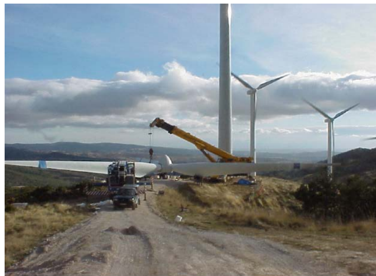
Figura 2-5: Ingombro del rotore a terra
