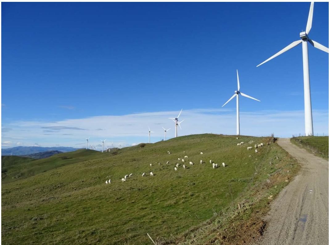
Figura 2-10: Vista sugli aerogeneratori dal 15 al 24
