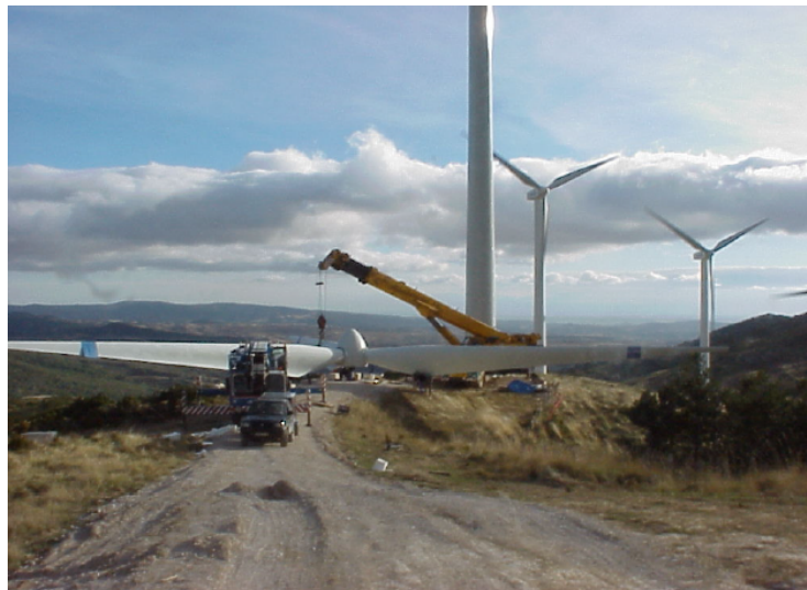
Figura 3-4: Ingombro del rotore a terra
