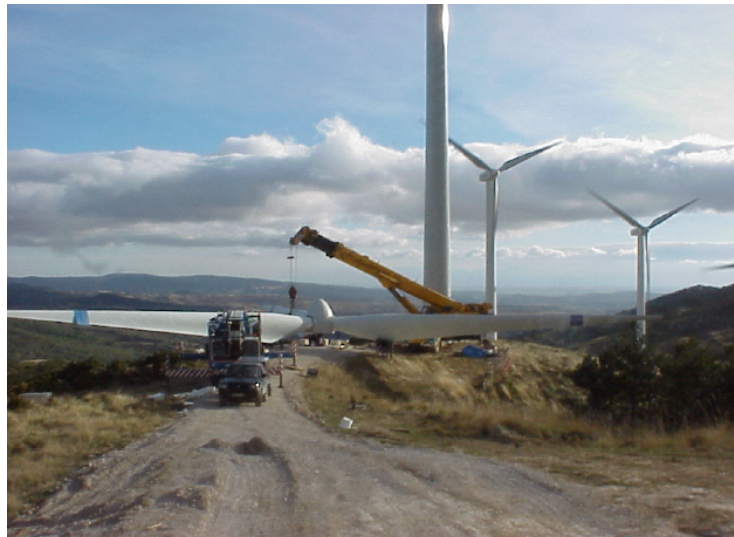
Figura 2-2: Ingombro del rotore a terra
