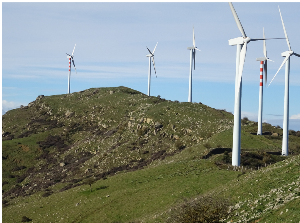
Figura 2-7: Vista sugli aerogeneratori dall'1 al 6
