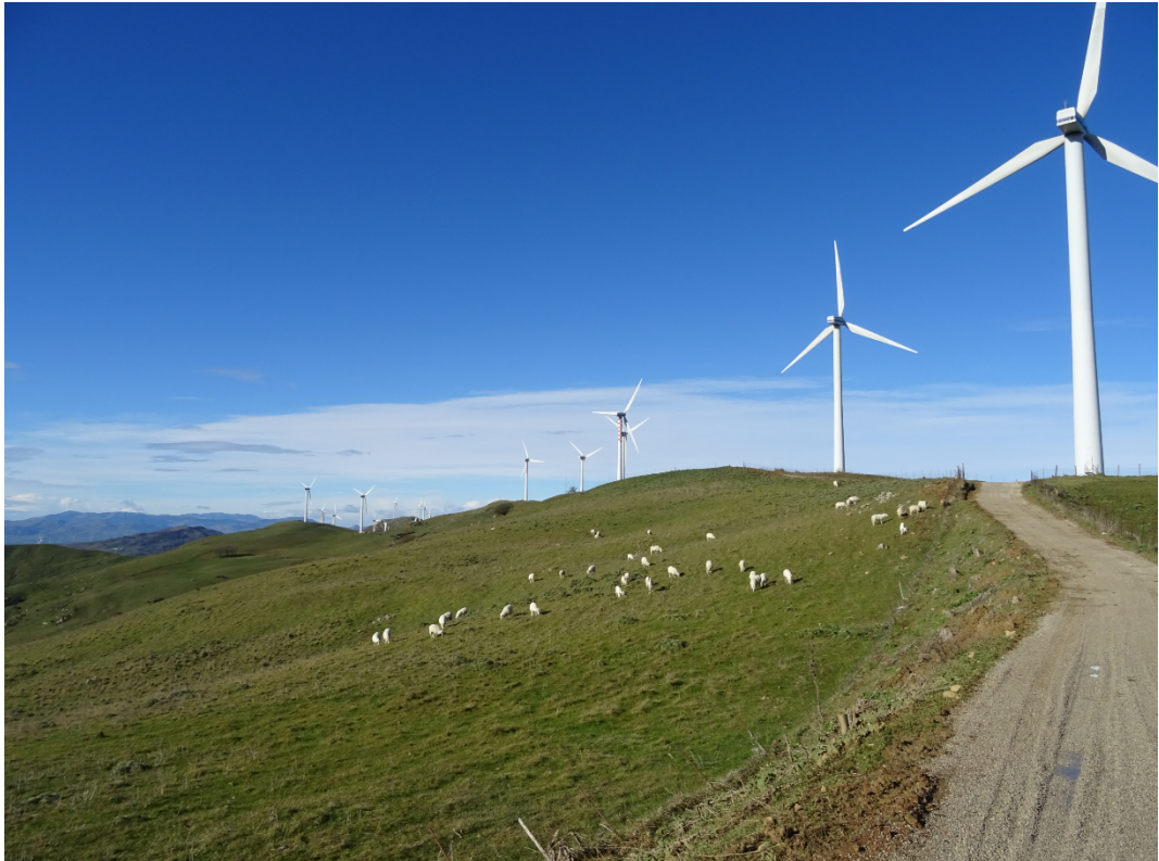
Figura 2-6: Vista sugli aerogeneratori dal 15 al 24
