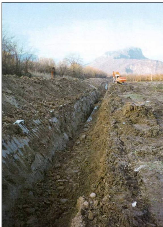
Fig. 2.7 - Operazione di rinterro della condotta
