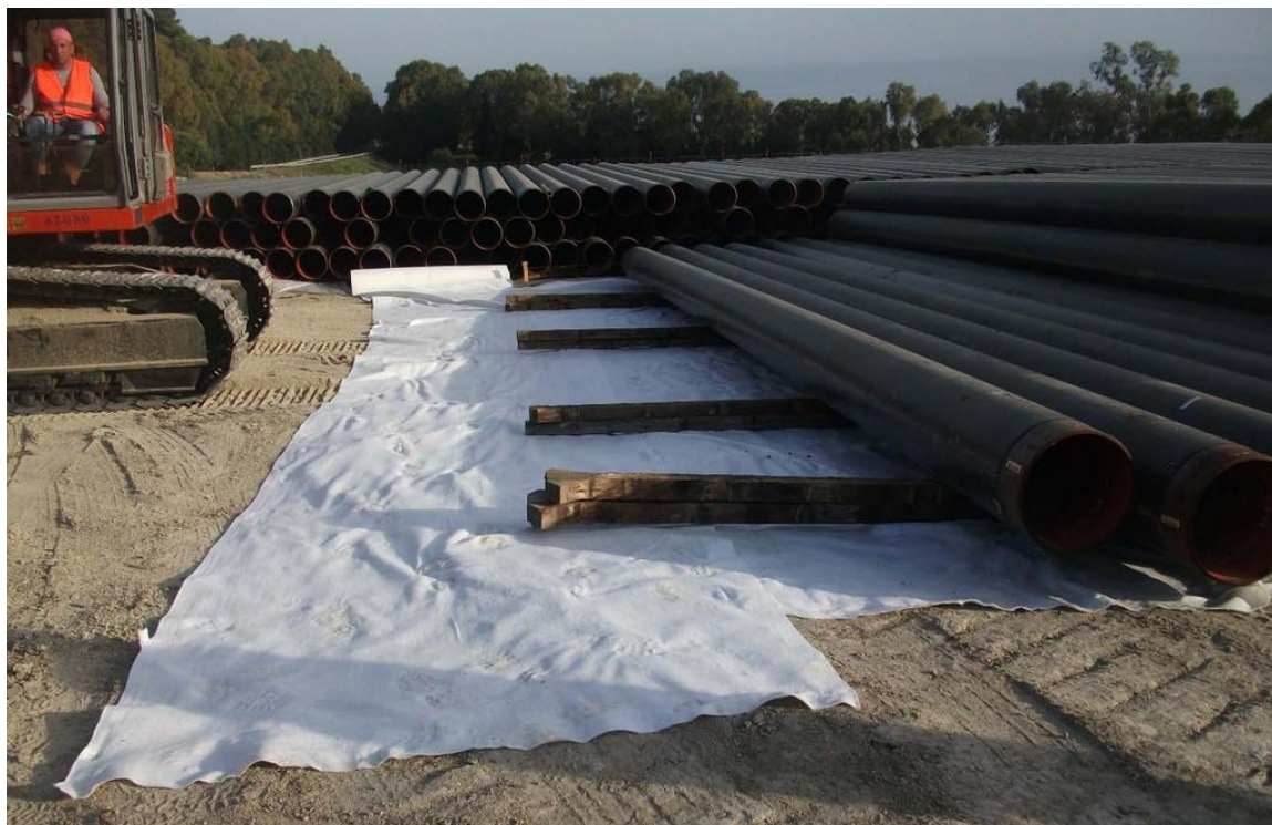
Fig. 2.3 - Piazzola di accatastamento tubazioni
