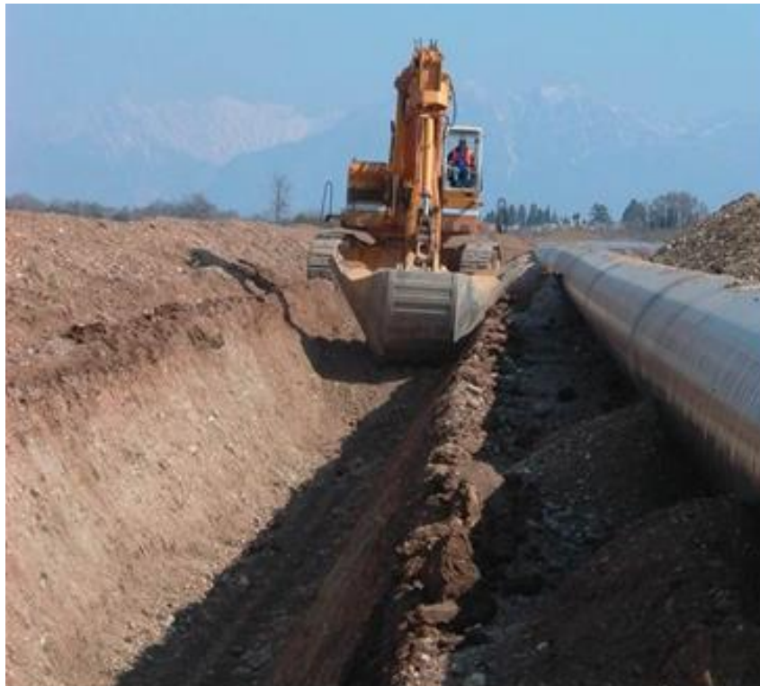
Fig. 2.5 - Scavo per l'alloggiamento della condotta
