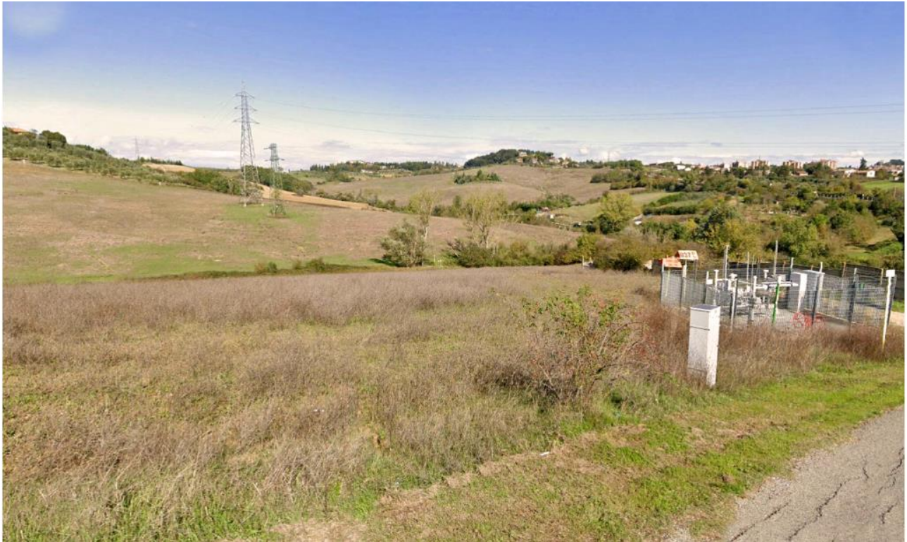
Fig. 5.10 – Stato attuale del PIDI 4103653/1.1 in rifacimento.
