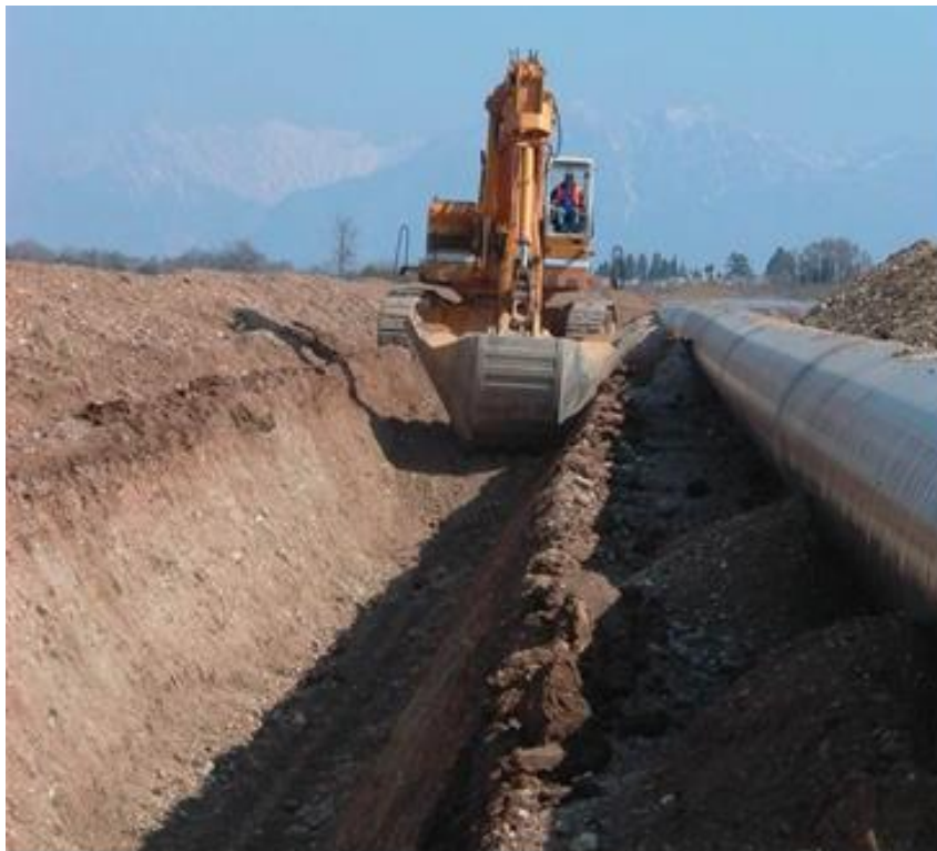
Fig. 9.3 - Scavo per l'alloggiamento della condotta
