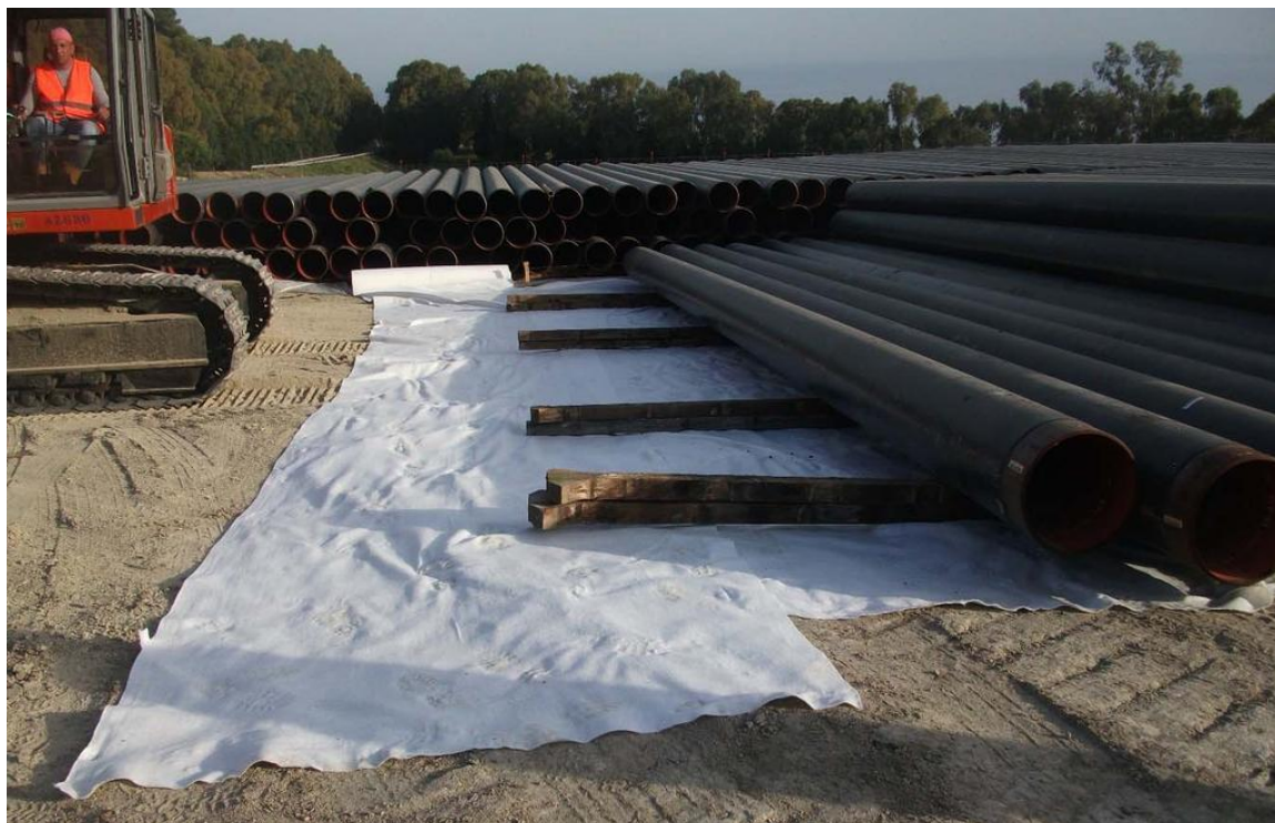
Fig. 9.1 - Piazzola di accatastamento tubazioni
