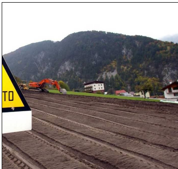
Fig. 9.6 - Ridistribuzione dello strato humico superficiale
