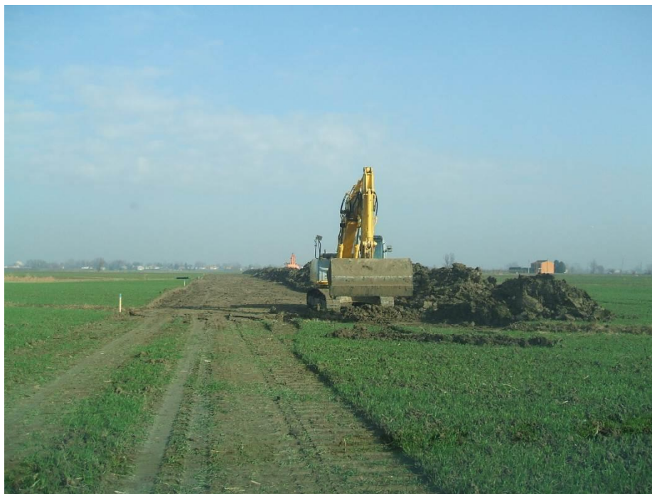
Fig. 9.2 - Apertura area di passaggio in area agricola
