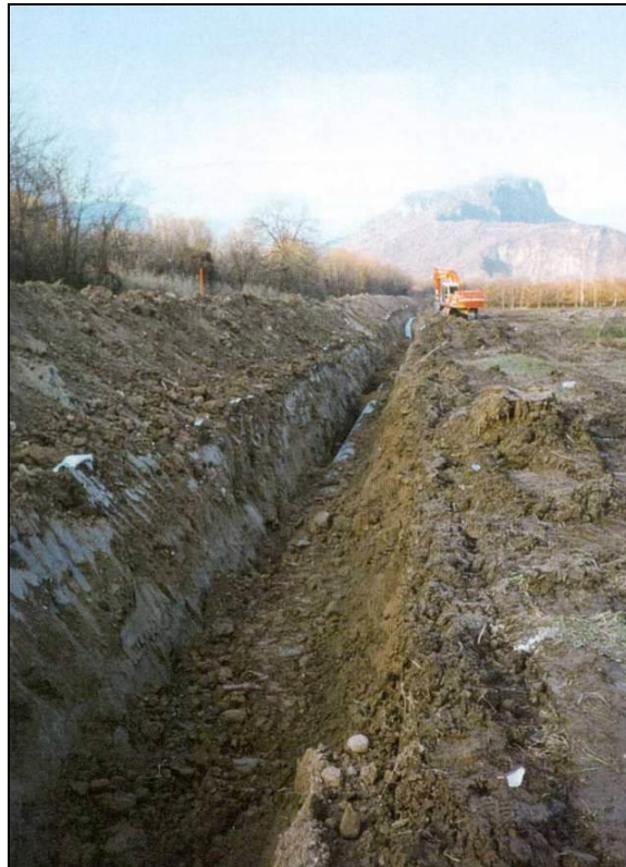
Fig. 9.5 - Operazione di rinterro della condotta
