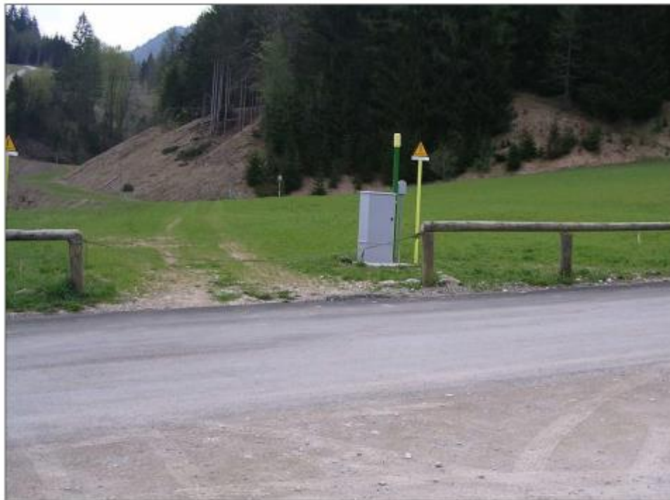
Fig. 9.10 - I cartelli segnalatori del metanodotto ed i tubi di sfiato posti in corrispondenza degli attraversamenti eseguiti con tubo di protezione.
