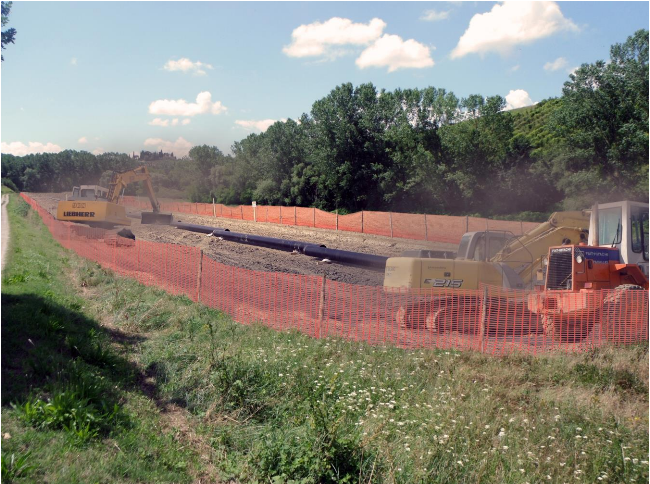
Fig. 5.2 – Apertura dell'area di passaggio.
