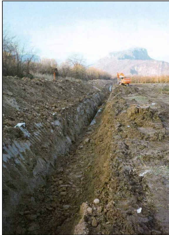
Fig. 3.4 - Operazione di rinterro della condotta
