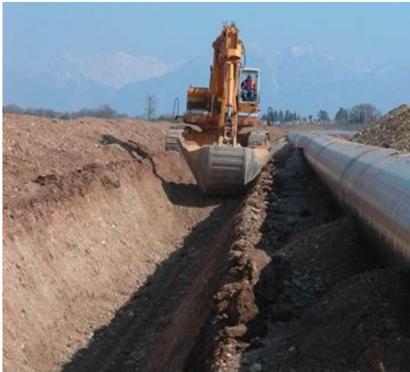
Fig. 3.2 - Scavo per l'alloggiamento della condotta
