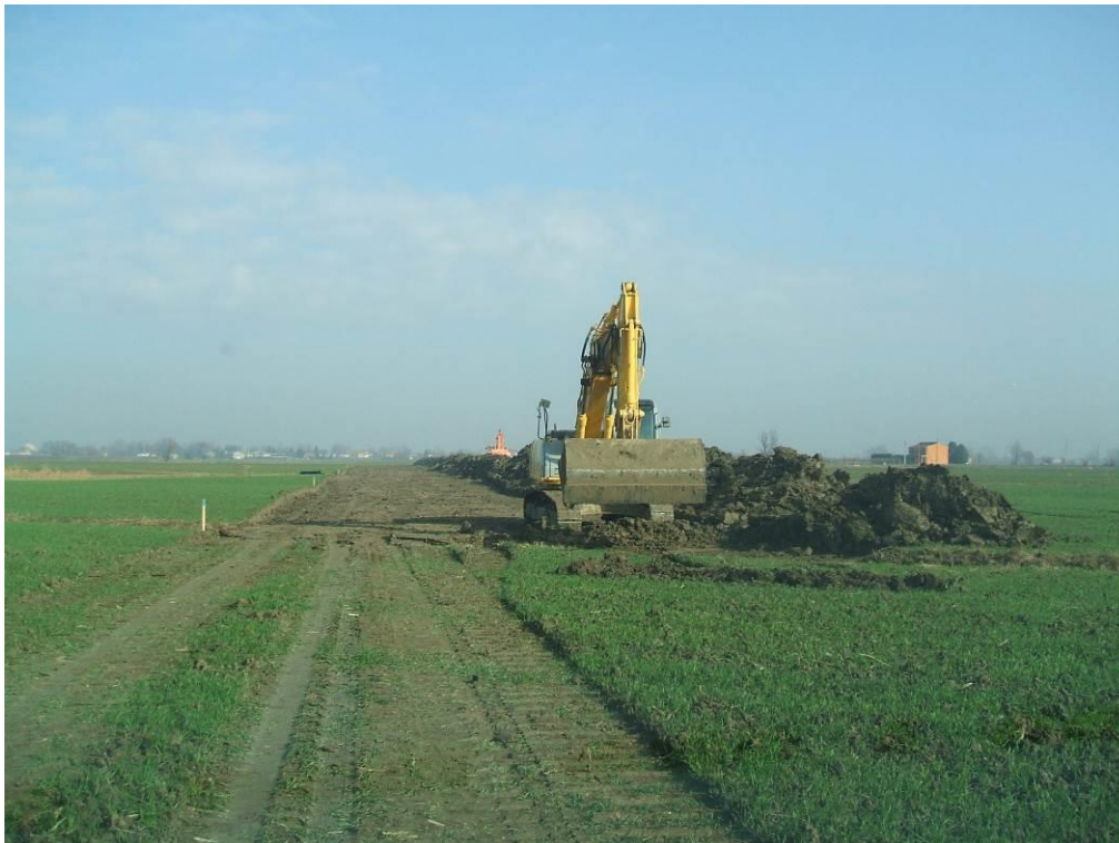
Fig. 3.1- Apertura area di passaggio in area agricola
