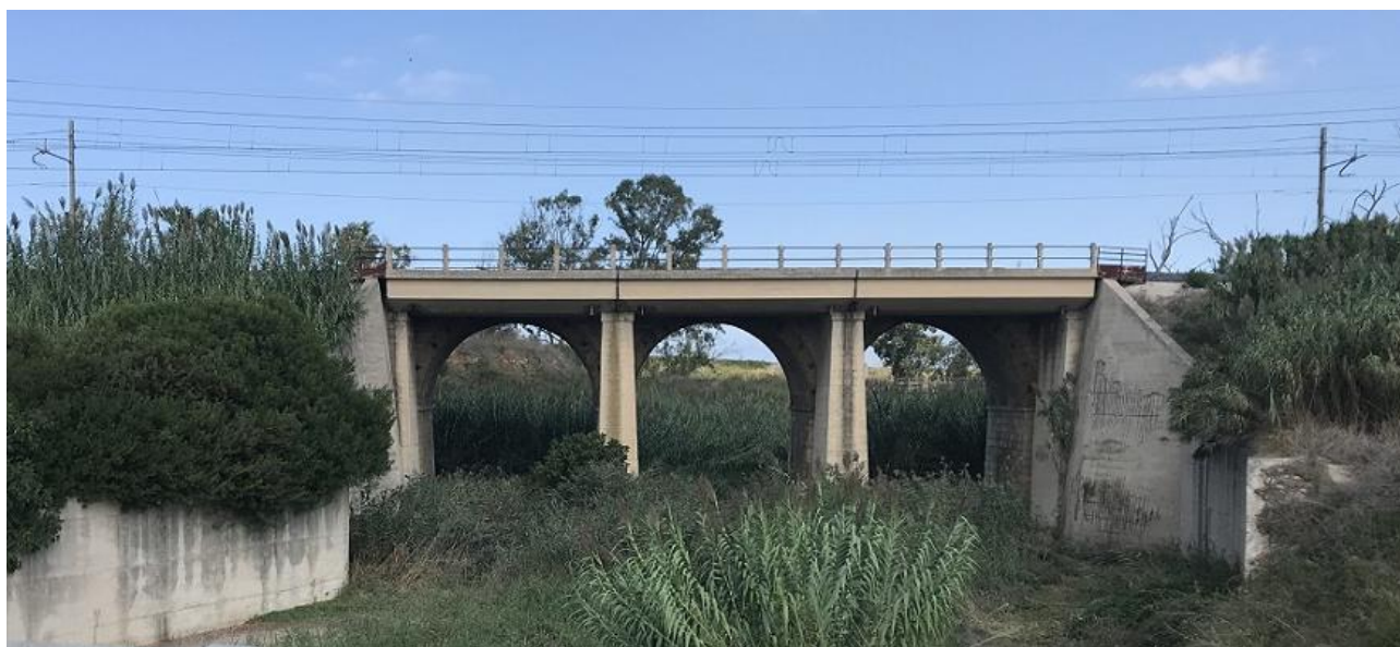
Figura 6 – Attraversamento ferroviario esistente sul Canale Cillarese.
