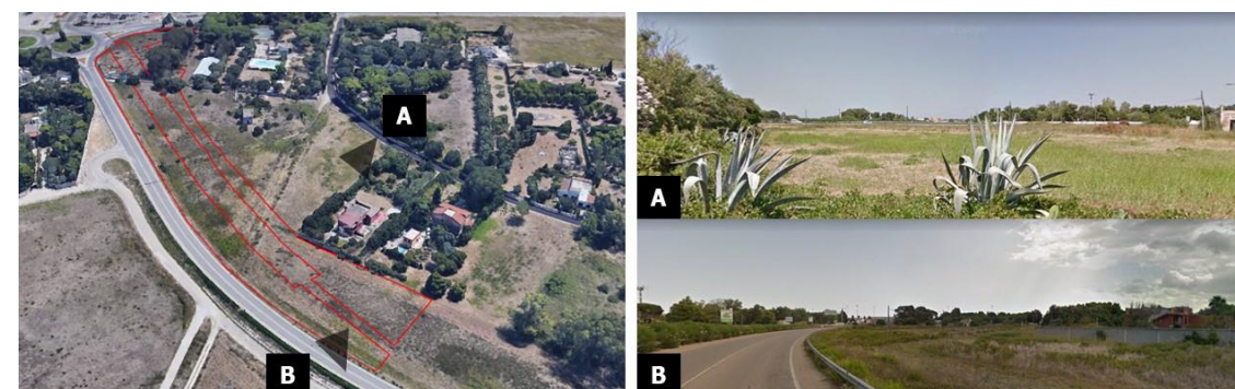
Figura 4-8 Ambito percettivo con la localizzazione delle aree di cantiere e tipologie di visuali esperibili.
