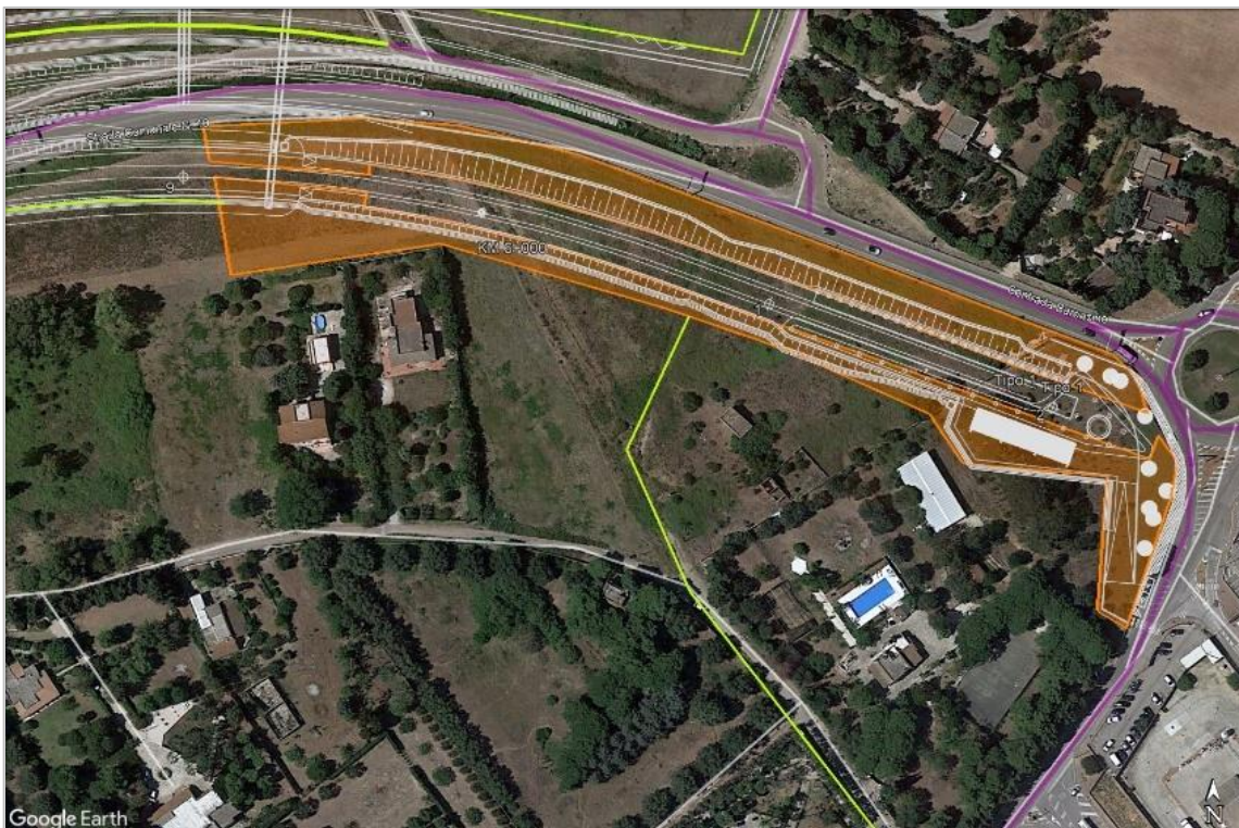
Vista aerea dell'area di cantiere A.T.08 e A.T.09 (ortofoto da Google Satellite, aggiornamento 2018)
