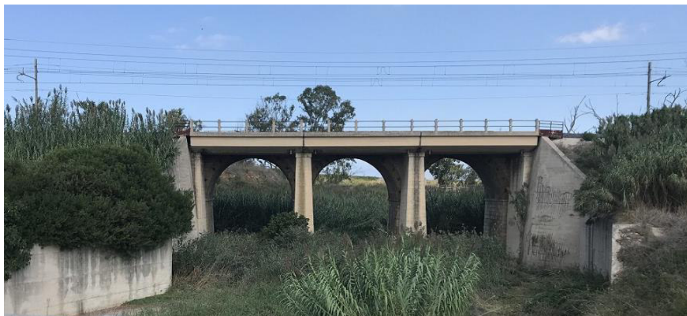
Figura 18 – Attraversamento ferroviario esistente sul Canale Cillarese.
