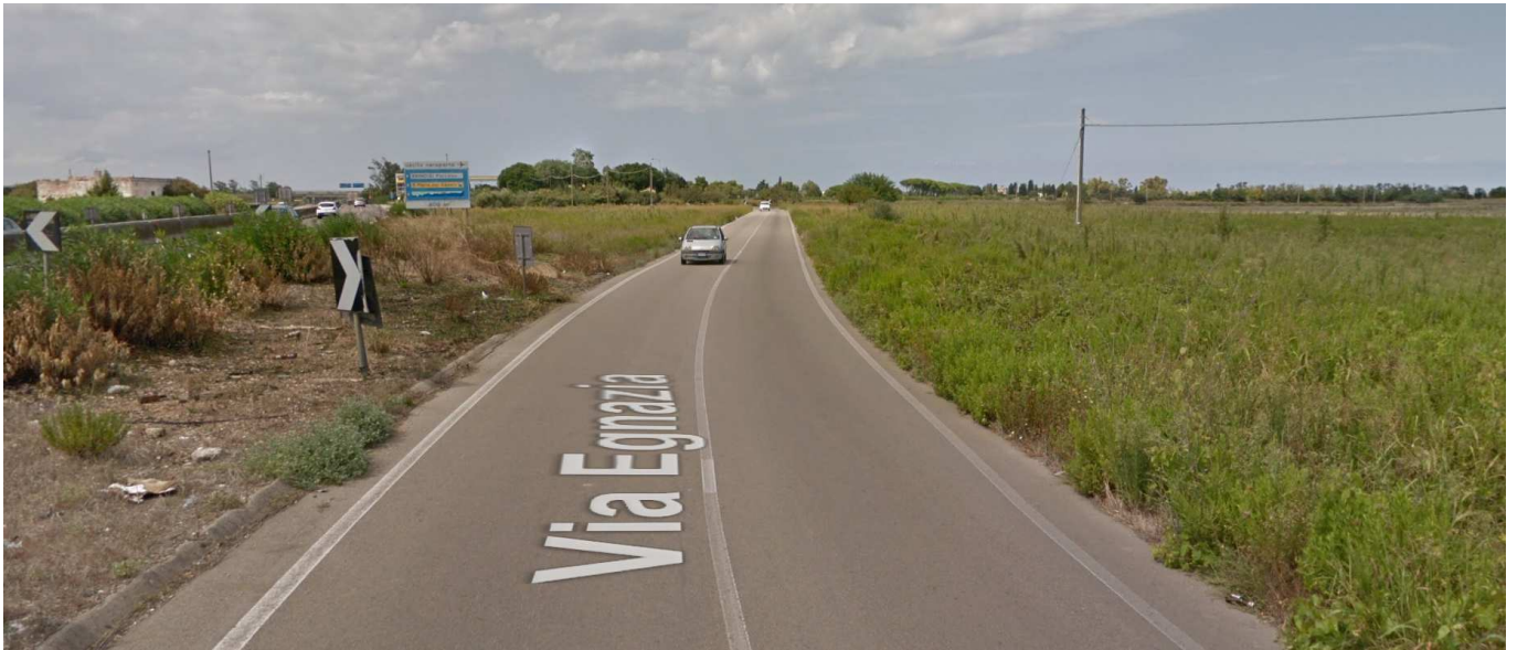
Foto 1 - Ingresso Sud da Via Egnazia
