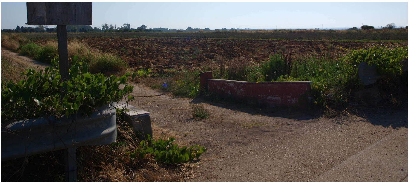
Foto 2 – Ingresso da Contr. SS379
