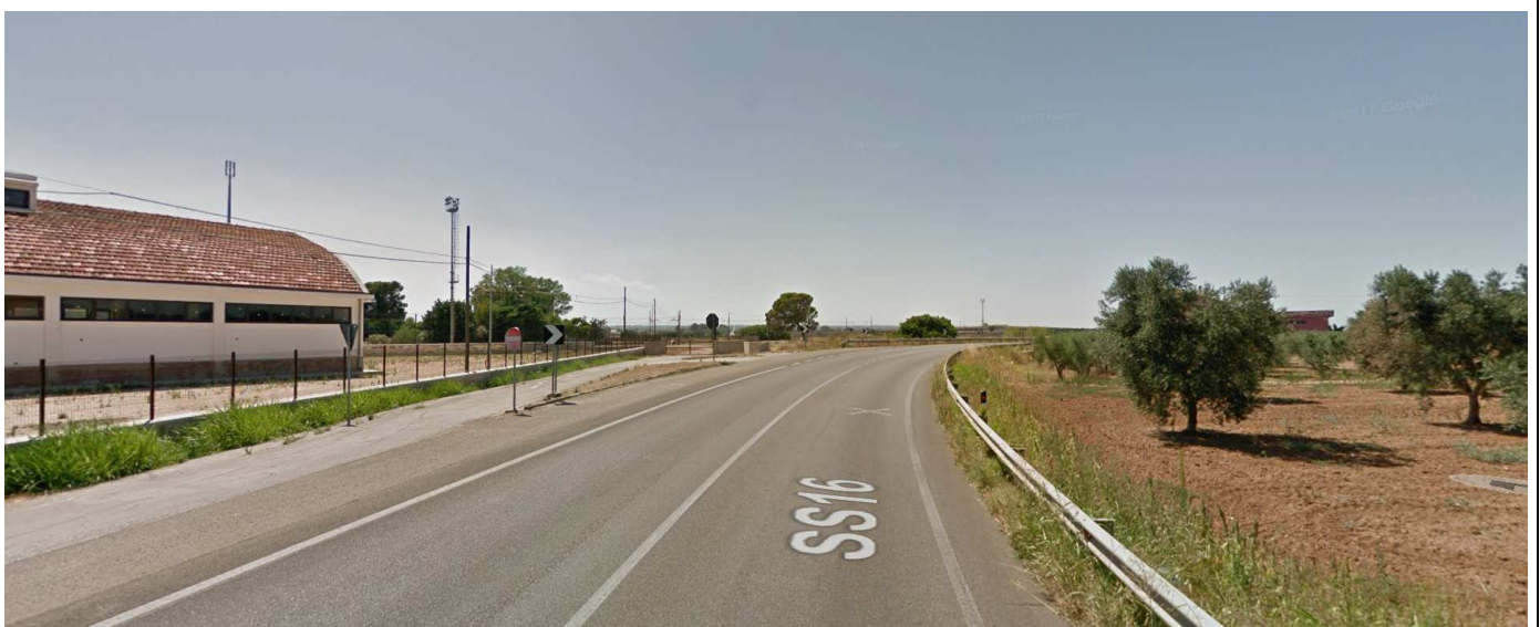
Foto 1 - Ingresso da Via Tacito
