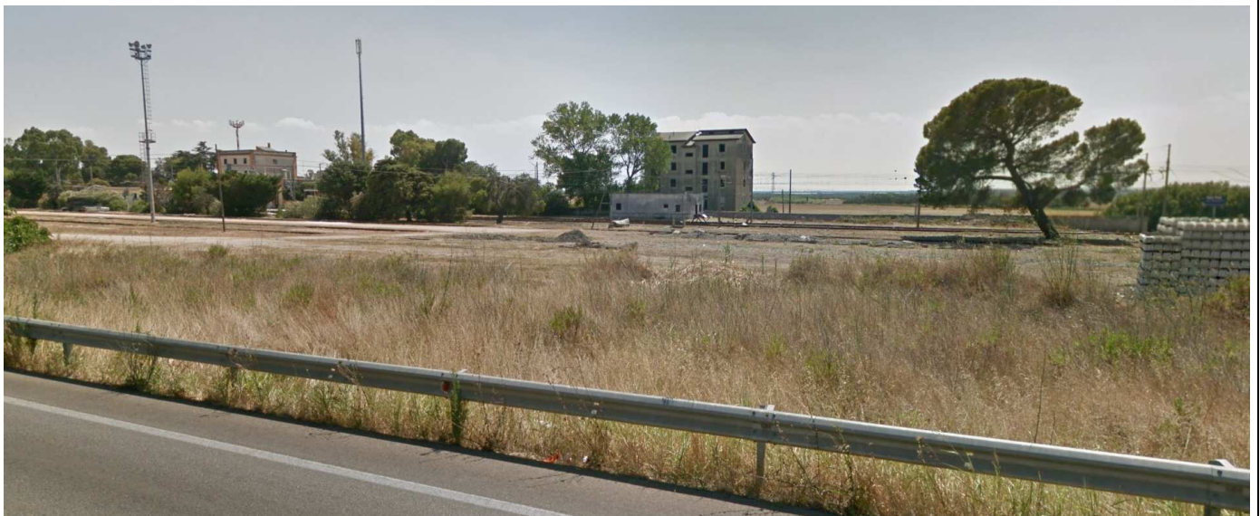
Foto 2 - Vista del piazzale FS
