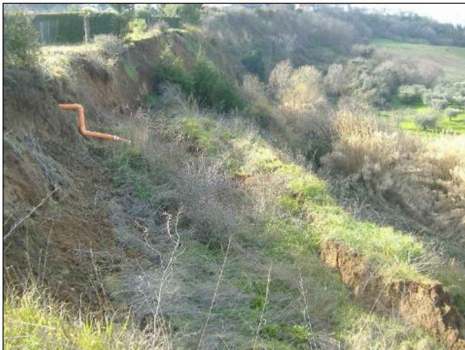
Figura 8-26 Località "Cava della Ripa" – Terrazzamenti lungo il fronte di frana (F7).
