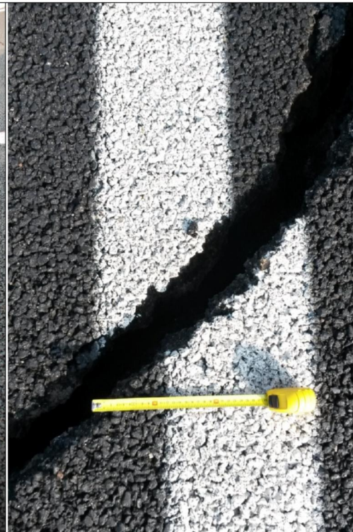
(35) Lesione D6 - Slittamento tra fronti della lesione
