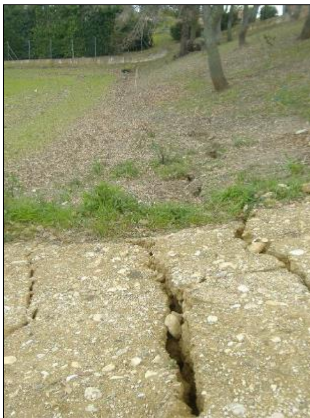
Figura 8-31 Fratture nei terreni adiacenti la S.P. litoranea direzione ovest (F.12).
