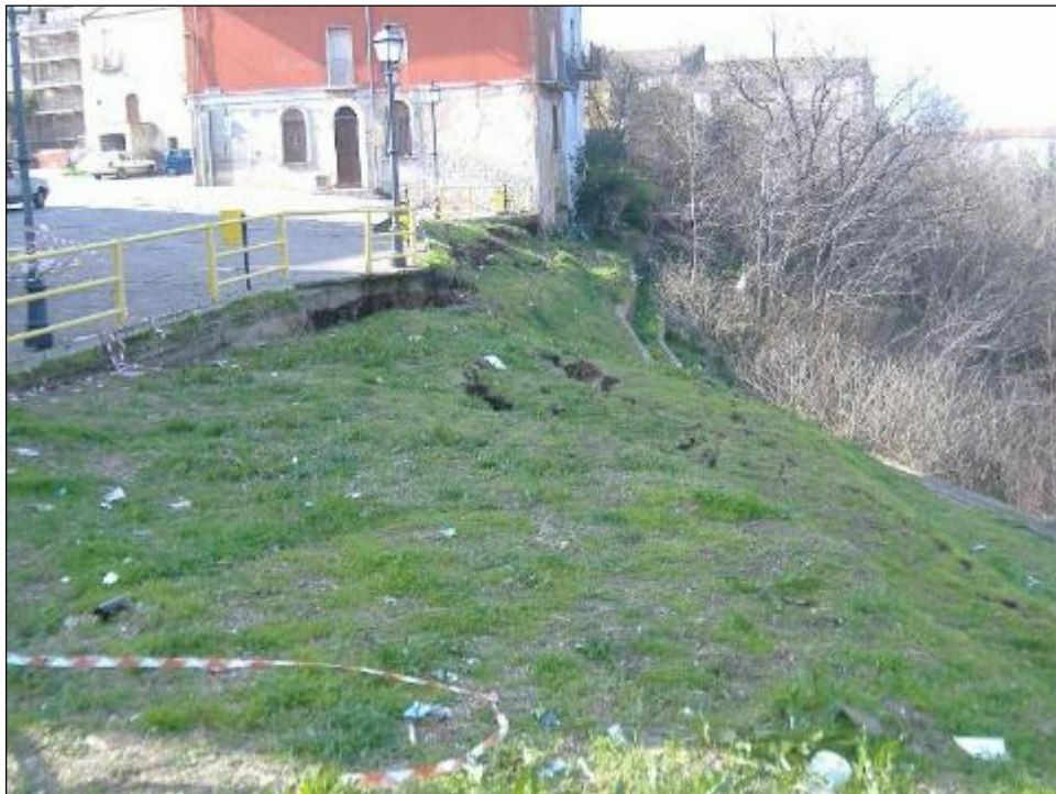
Figura 8-22 Continuazione verso Nord Ovest delle fratture di Figura 8-21 (F.2).
