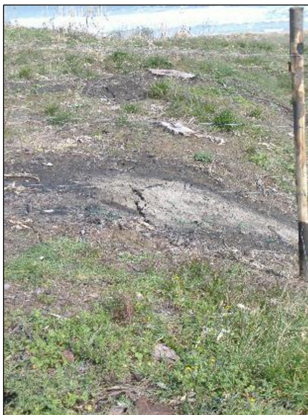
Figura 8-42 Fratture nel terreno in adiacenza alla s.s. 16 adriatica (F.23).
