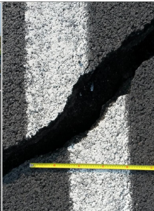
(45) Lesione S5 - Slittamento tra fronti della lesione
