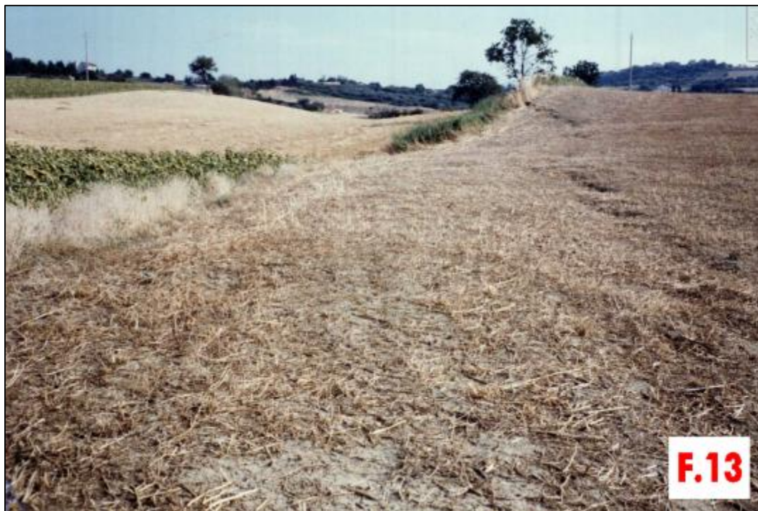
Figura 8-13 Continuazione a valle della strada della lesione di Figura 8-12 (F13).
