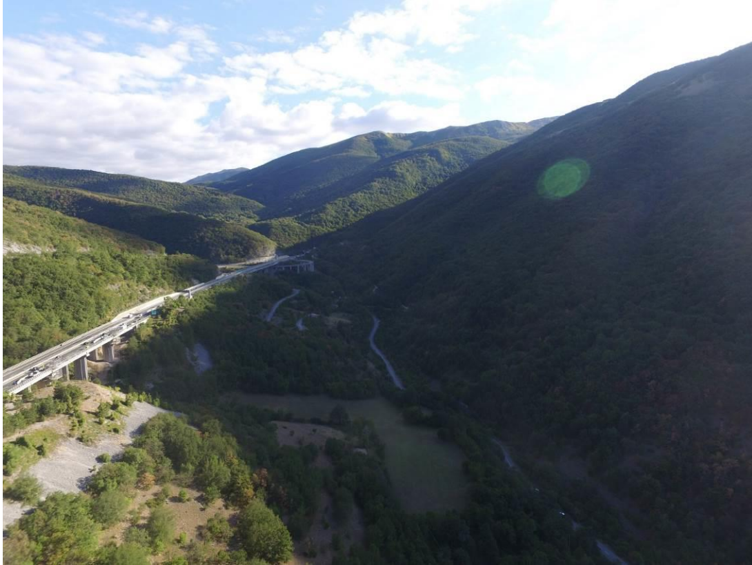
Figura 2-7 - Vista d'insieme del tracciato (verso Roma - svincolo di Tornimparte al centro della foto)
