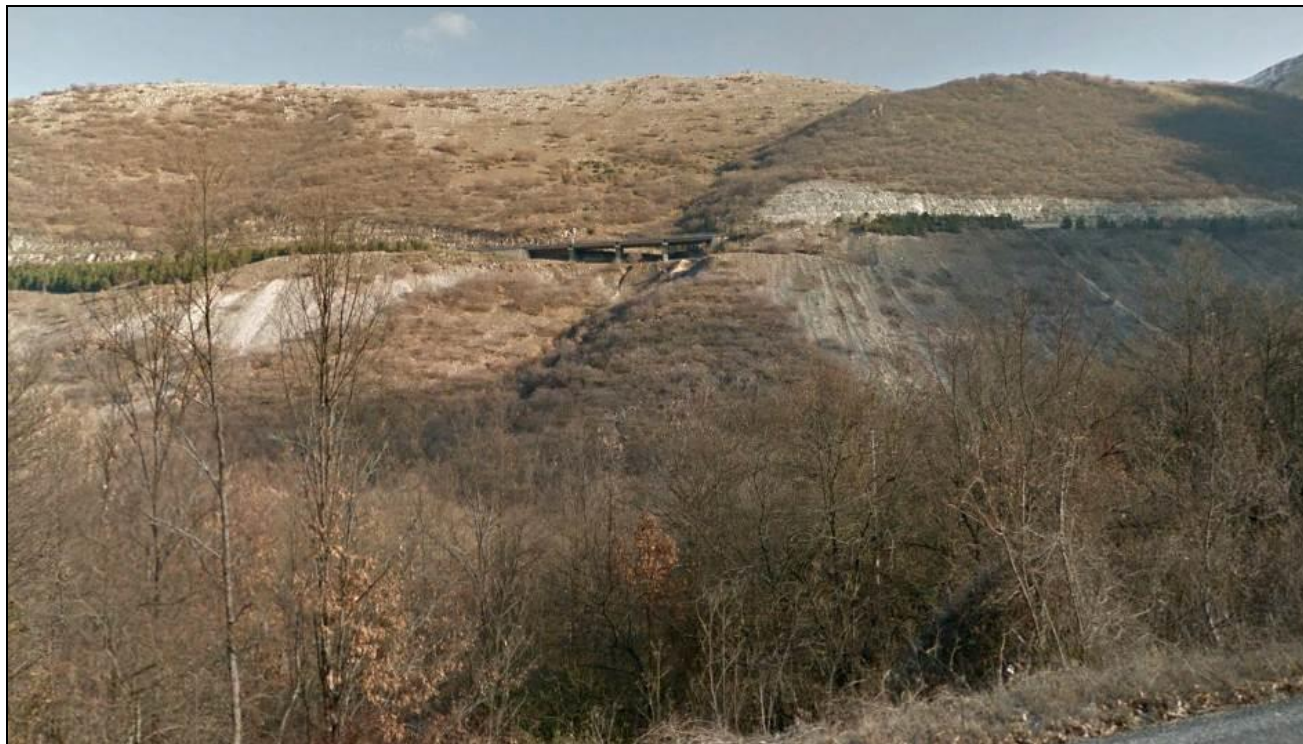
Figura 5-11 Vista del Viadotto Vaccarini dalla SP1
