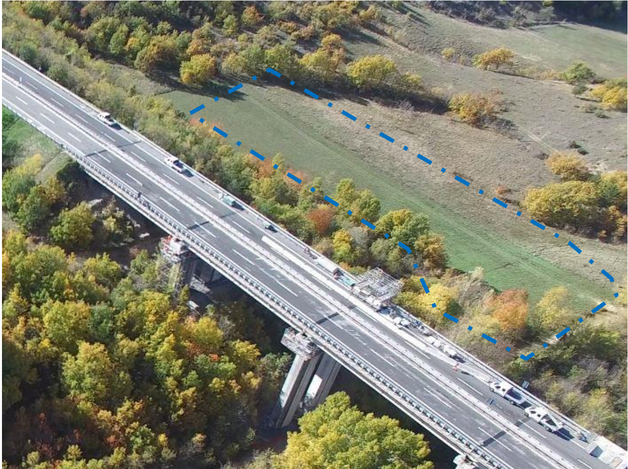
Figura 5-2 area del futuro campo base vista dal drone (zona delimitata in blu)
