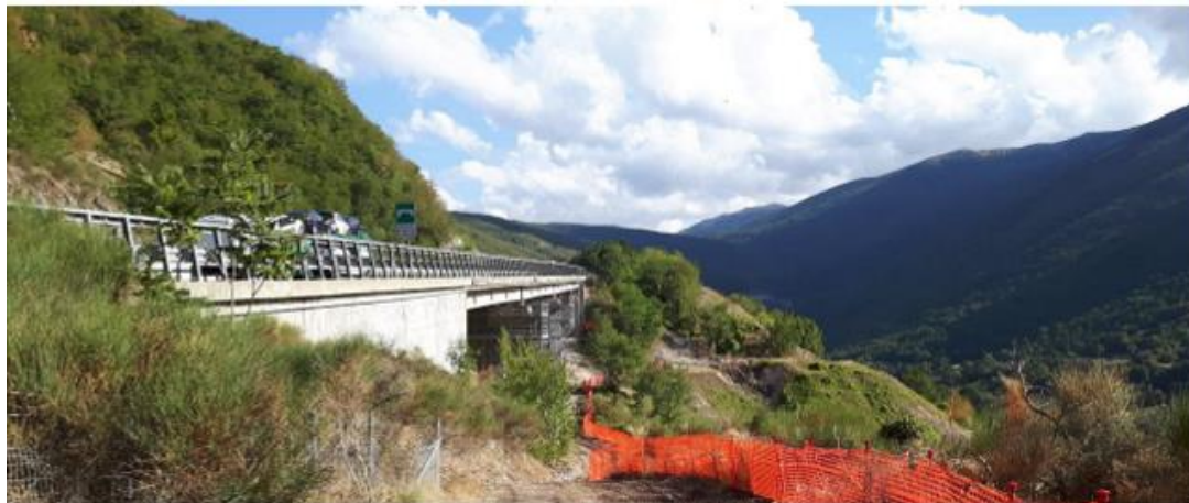
Figura 5-9 Veduta Viadotto Vaccarini
