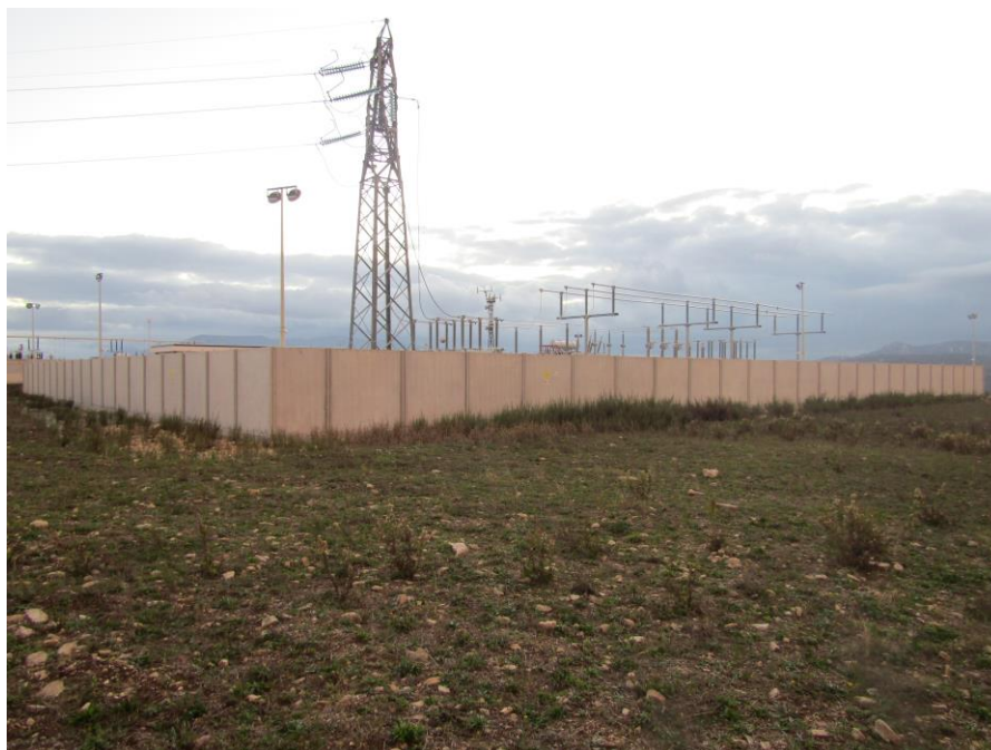
Stazione Elettrica esistente
