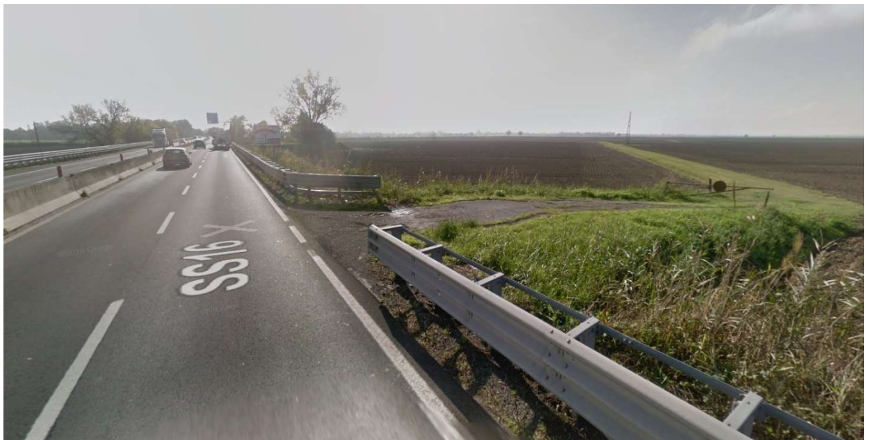
Figura 27: accesso km 152+470 dir. Nord
