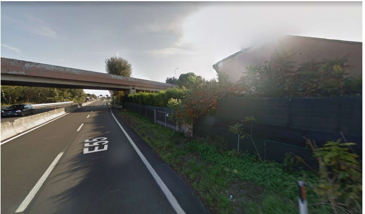
Figura 25: accesso km 151+160 dir. Sud
