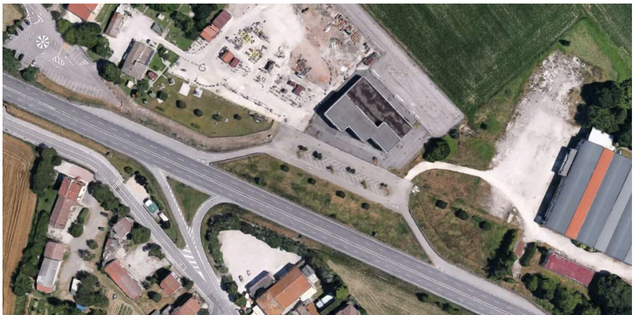
Figura 31: accessi km 153+670 e km 154+000 dir. Nord
