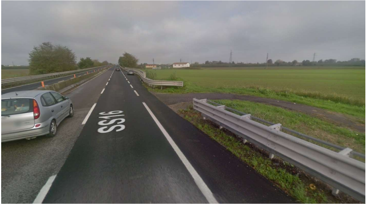
Figura 28: accesso km 152+470 dir. Sud
