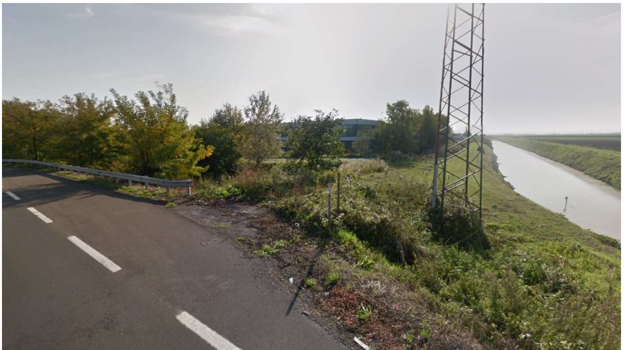
Figura 21: accesso km 148+800 dir. Sud
