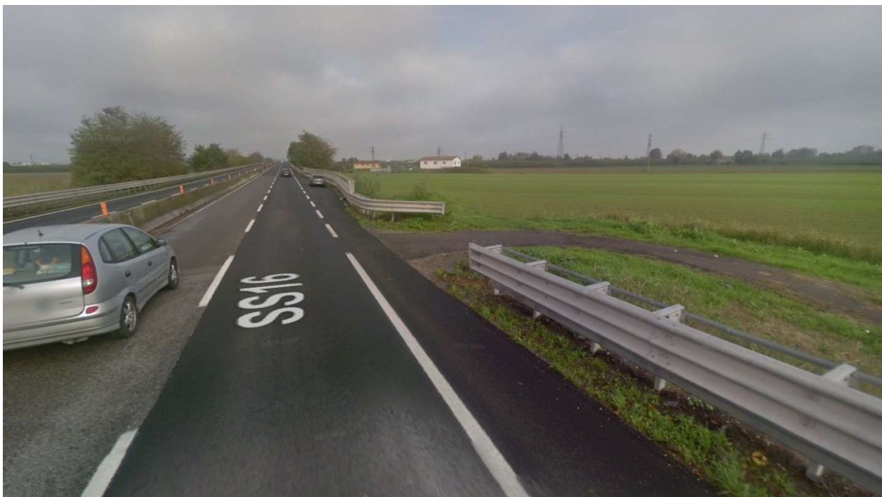
Figura 10: accesso km 152+470 dir. Nord
