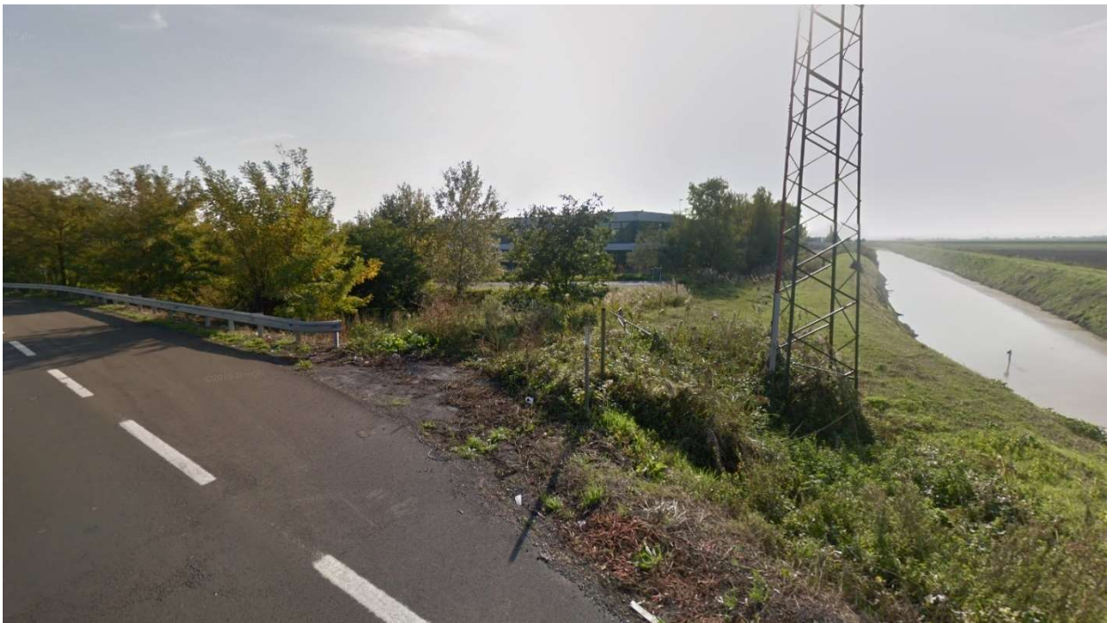
Figura 1: accesso km 148+800 dir. Sud
