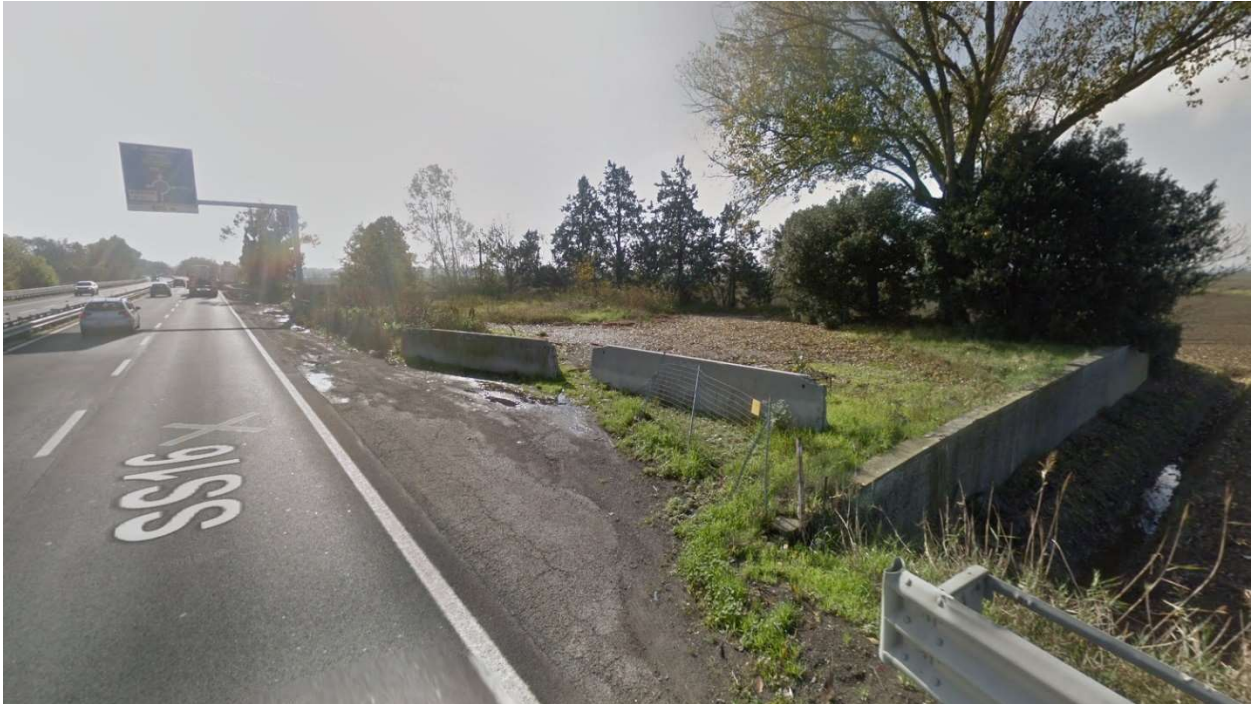
Figura 12: accesso km 152+575 dir. Sud
