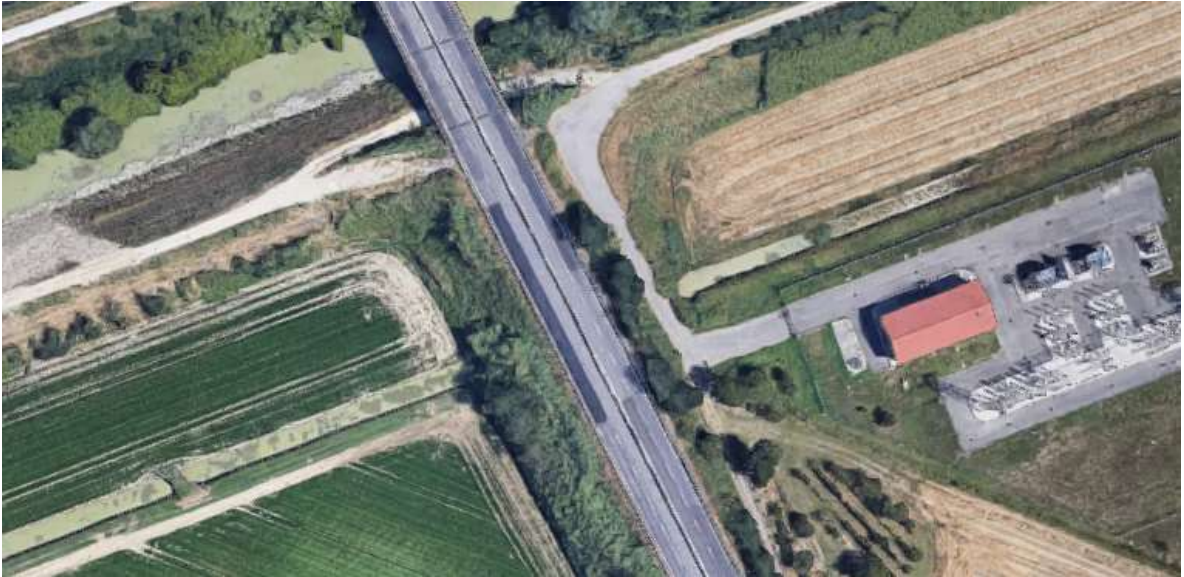
Figura 29: Viabilità secondaria km 152+050
