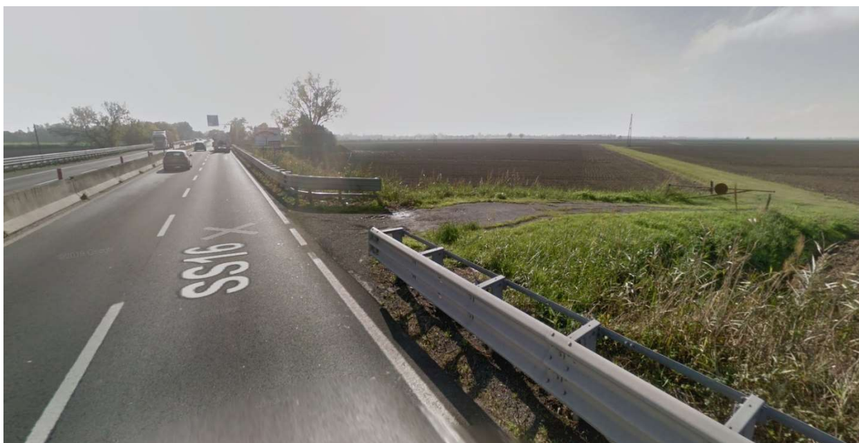
Figura 9: accesso km 152+470 dir. Sud
