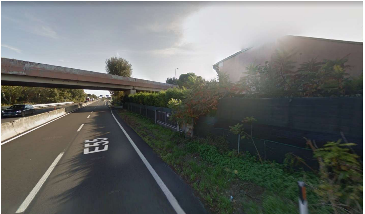
Figura 7: accesso km 151+160 dir. Sud
