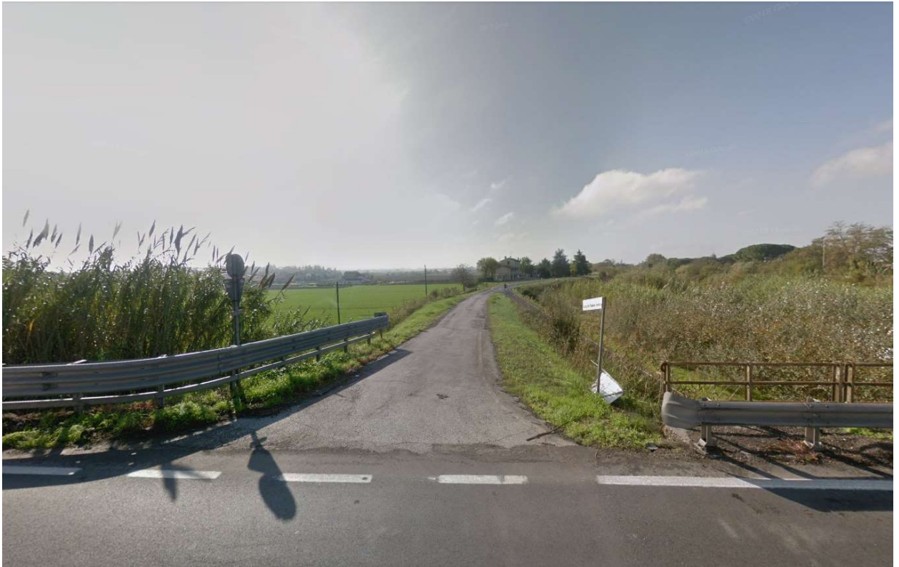
Figura 13: accesso km 153+400 dir. Sud
