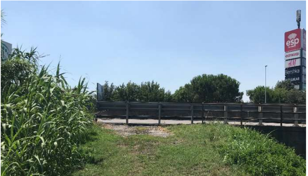
Figura 8: accesso km 151+640 dir. Nord
