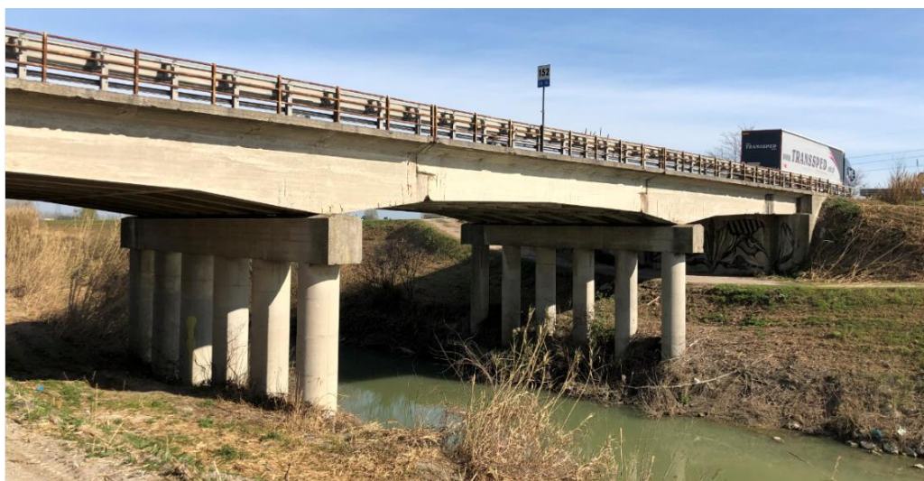
Figura 15: Vista del ponte sul fiume Montone
