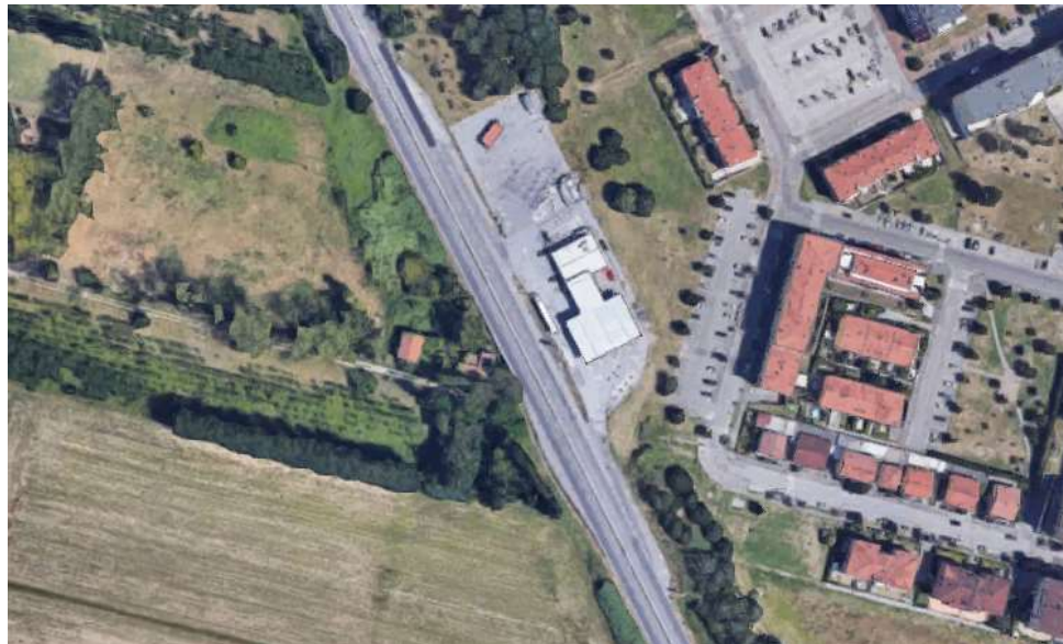
Figura 3: Stazione di rifornimento al km 150+200
