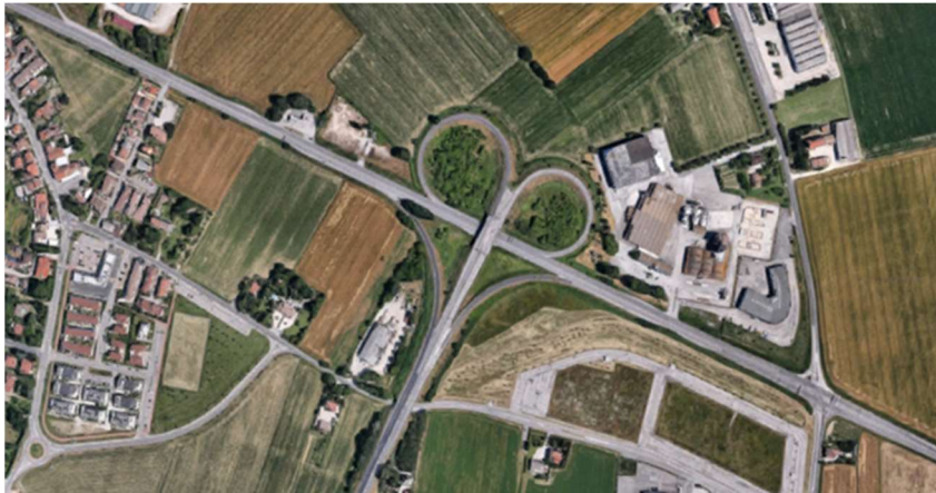
Figura 8: S.S. 3bis al km 154+550
