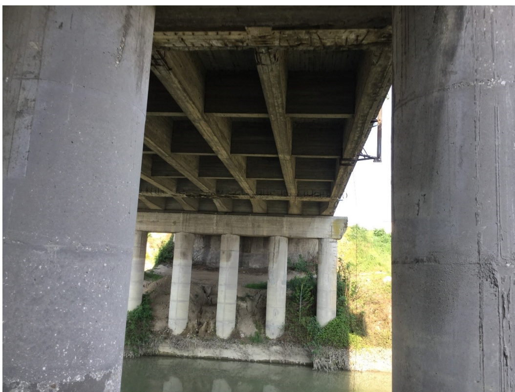
Figura 6 Vista intradosso impalcato
