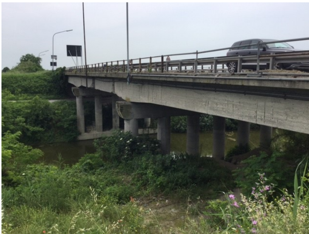
Figura 5 Vista laterale Ponte
