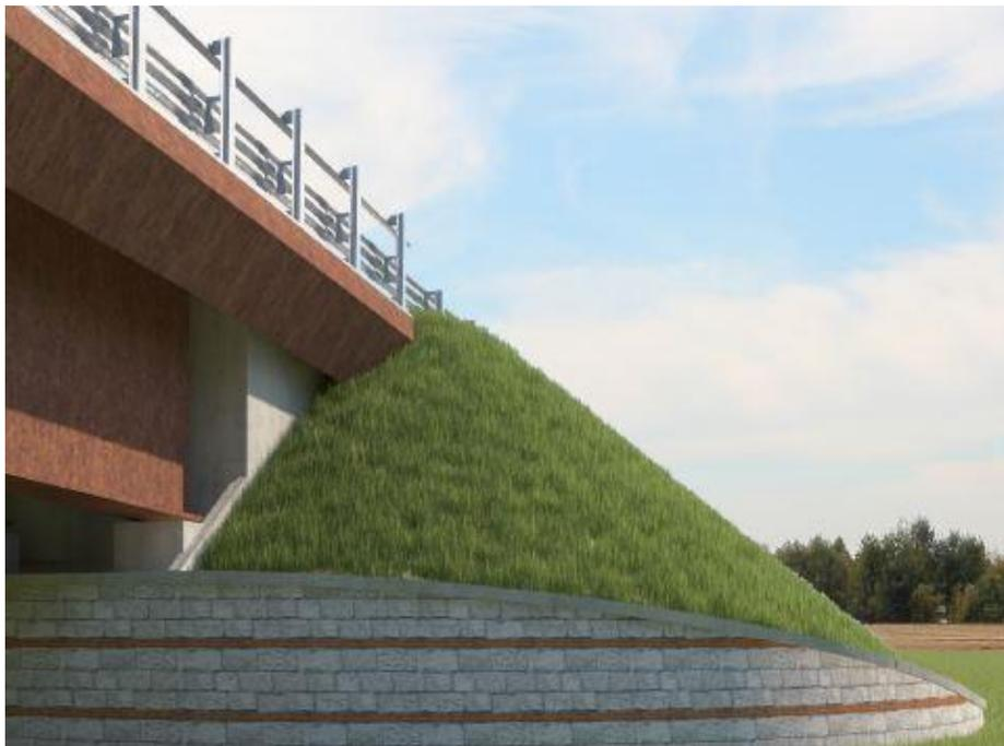
FIGURA 2-20 MURO DI SOTTOSCARPA IN CORRISPONDENZA DELLE SPALLE DEI VIADOTTI
