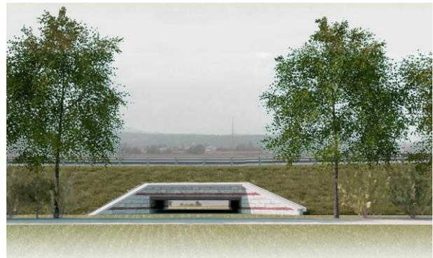
**FIGURA 5-32 FORNICE, ATTRAVERSAMENTO FAUNISTICO, VISTA VIRTUALE**
