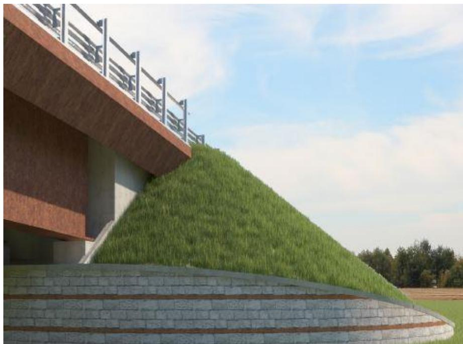
**FIGURA 5-23 MURO DI SOTTOSCARPA IN CORRISPONDENZA DELLE SPALLE DEI VIADOTTI**
