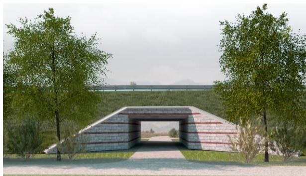
**FIGURA 5-29 FORNICE, ATTRAVERSAMENTO FAUNISTICO, SOTTOPASSO AGRICOLO – VISTA VIRTUALE**
