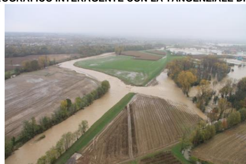
FIGURA 4-15: LA ROTTA DEL FIUME TIMONCHIO-BACCHIGLIONE A CALDOGNO DURANTE L'EVENTO ALLUVIONALE DEL 2010
