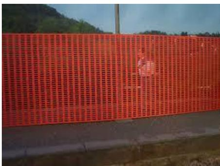
Recinzione, sbarramenti, protezioni, segnalazioni e avvisi devono essere mantenuti in buone condizioni e resi ben visibili per tutta la durata dei lavori, **adottando dispositivi provvisori atti a garantire condizioni di estrema stabilità e solidità in ogni condizione atmosferica e durante tutte le fasi esecutive.**
