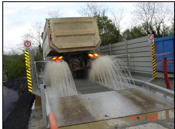
Alternativamente all'installazione di impianti di lavaggio ruote per abbattere all'origine il rischio di rilascio sostanze fangose (da parte degli autocarri da e per il cantiere) nelle immediate vicinanze degli accessi sulla viabilità pubblica, potrà essere effettuata la pulizia di quest'ultima con moto spazzatrici stradali.
