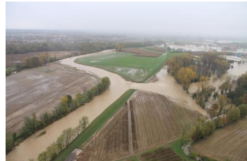
FIGURA 5-66: LA ROTTA DEL FIUME TIMONCHIO-BACCHIGLIONE A CALDOGNO DURANTE L'EVENTO ALLUVIONALE DEL 2010
