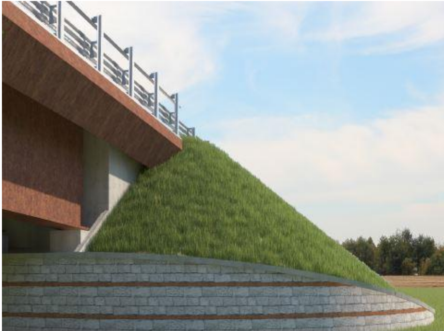
FIGURA 8-61 MURO DI SOTTOSCARPA IN CORRISPONDENZA DELLE SPALLE DEI VIADOTTI
