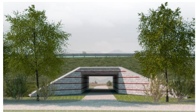
FIGURA 8-36 FORNICE, ATTRAVERSAMENTO FAUNISTICO, SOTTOPOSTO AGRICOLO – VISTA VIRTUALE
