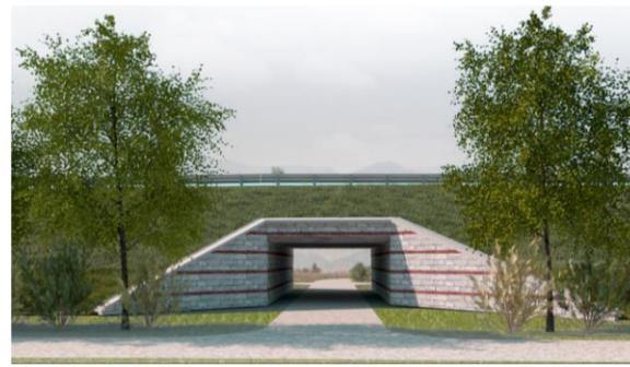
FIGURA 5-39 FORNICE, ATTRAVERSAMENTO FAUNISTICO, SOTTOPOSTO AGRICOLO – VISTA VIRTUALE
