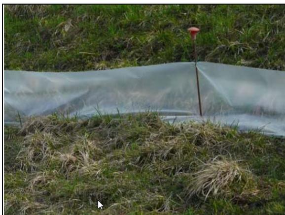
Fig. 11/C – Barriera per erpetofauna esempio con telo in polietilene fermato da picchetto in ferro ed ancorato al terreno con filo di ferro e ganci ad “U” rovescio
