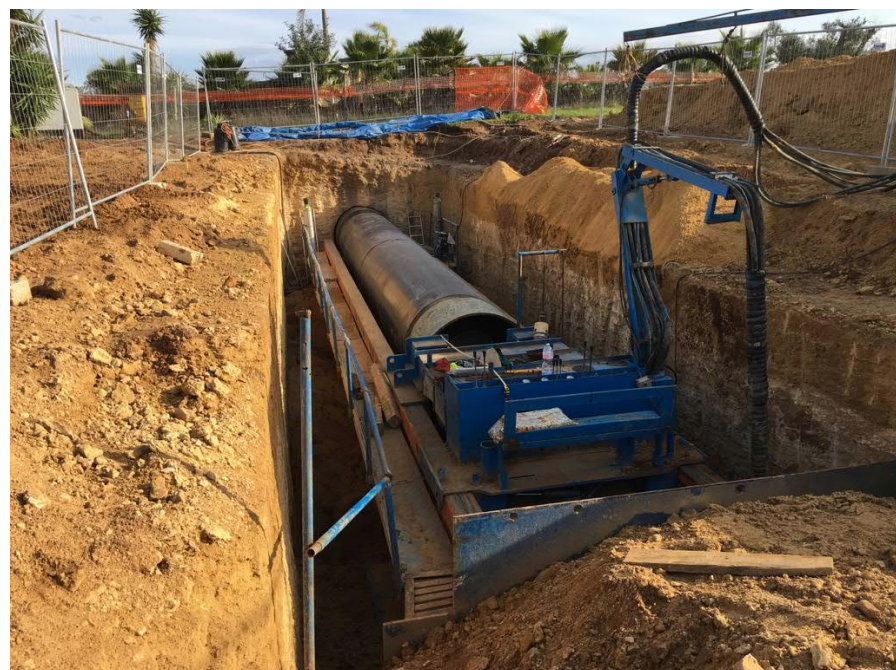
Fig. 2.b – trivellazione spingitubo della S.P. 236: perforazione e contemporanea infissione del tubo guaina in acciaio
