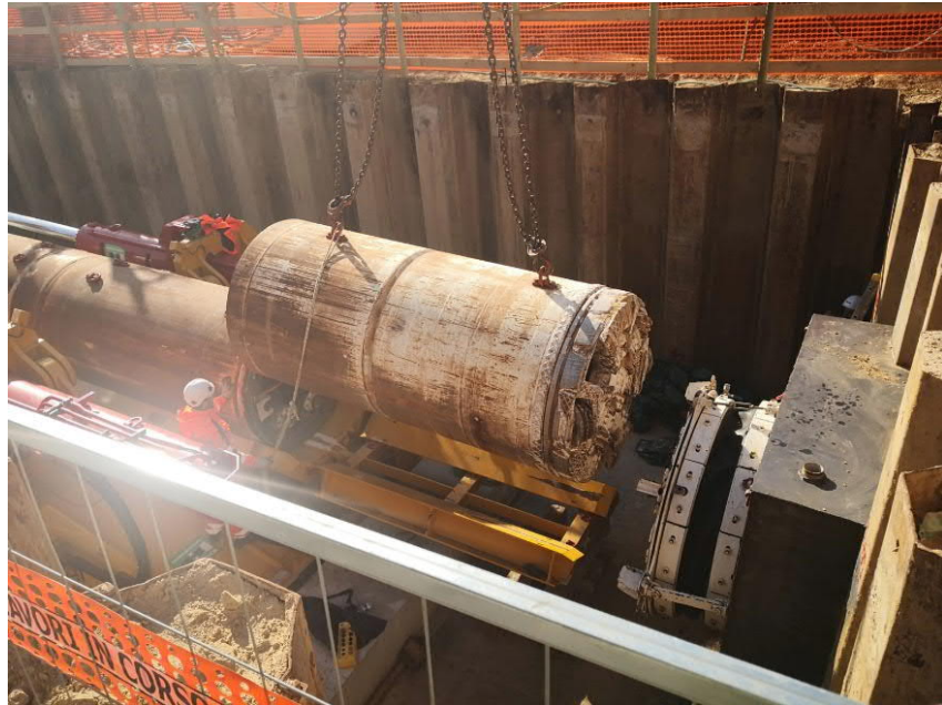
Fig. 1.a – posizionamento della fresa a scudo chiuso prima delle operazioni di perforazione
