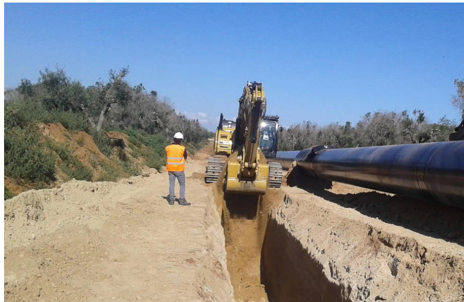
Fig. 1.b – fase di scavo della trincea con macchina escavatrice tradizionale
