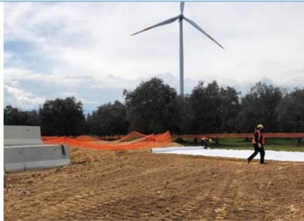
Realizzazione area di deposito smarino con posa in opera di TNT
