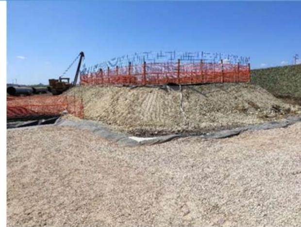
Vasca raccolta dei fanghi con geomembrana impermeabilizzante in HDPE
