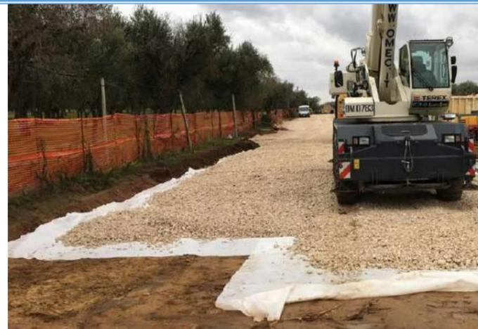
Preparazione area di cantiere con misto cava previa stesura di TNT
