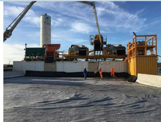
Impermeabilizzazione con geocomposito bentonitico area deposito smarino
