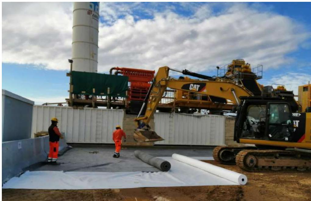
Fig. 1.a - Posa in opera di TNT e geocomposito per la realizzazione delle aree di deposito smarino presso l'area di cantiere dei microtunnel 'Lecce' e 'Lecce 1'.
