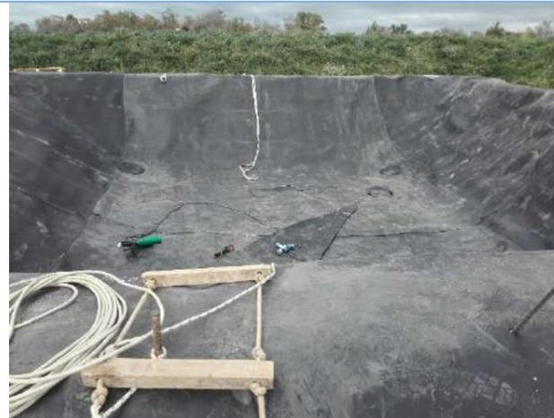
Preparazione vasca raccolta fanghi impermeabilizzata con geomembrana in HDPE
