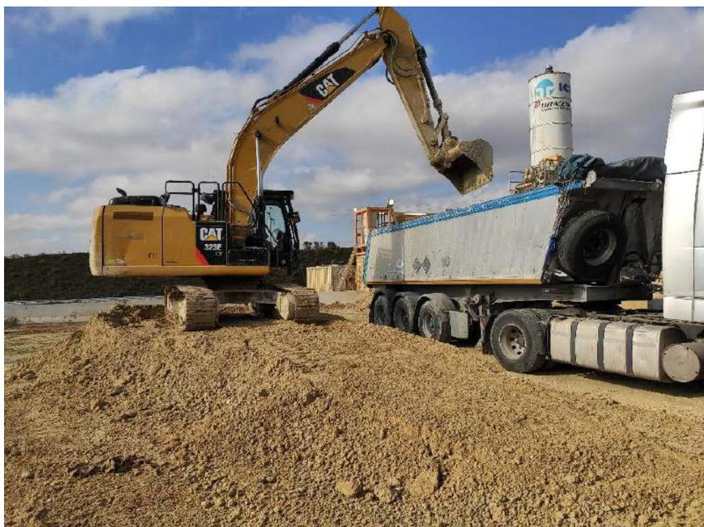
Fig. 1.c - Area di cantiere microtunnel 'S.P. 131': carico dello smarino su automezzo autorizzato e successivo trasporto verso impianto di recupero/smaltimento
