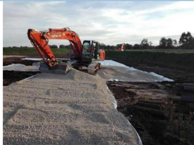
Realizzazione area movimentazione mezzi con misto cava previa stesura di TNT
