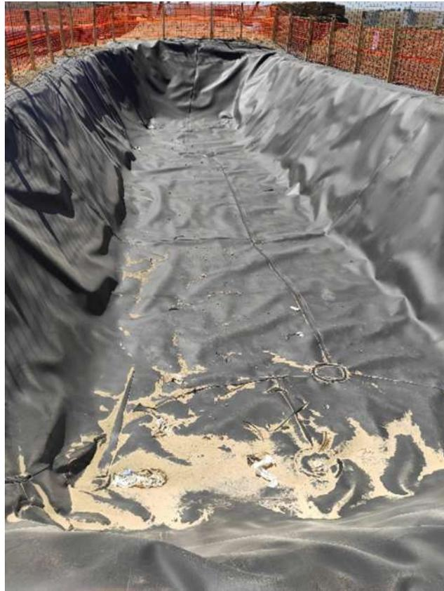
Fig. 2.a – Impermeabilizzazione vasca raccolta fanghi presso area cantiere microtunnel 'S.P. 131'
