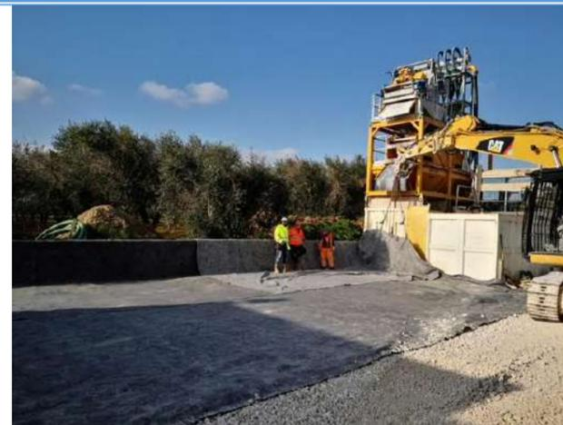
Realizzazione area deposito smarino impermeabilizzata con geocomposito bentonitico
