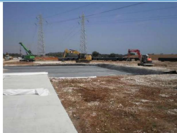
Realizzazione area di cantiere con misto cava previa stesura di TNT
