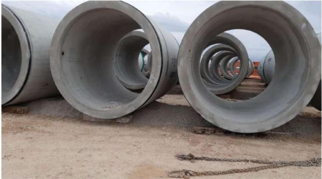
Fig.4.a - Conci in c.a. posti su stock in legno opportunamente separati dal suolo per mezzo di TNT e stabilizzato misto cava presso area di cantiere microtunnel 'Masseria Grande'
