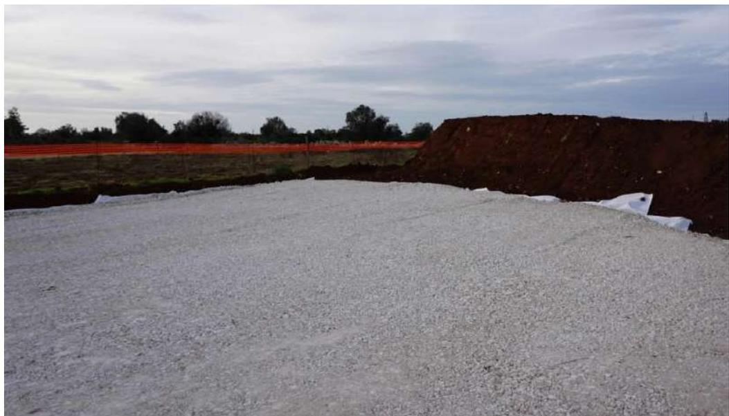
Fig. 3.a – Strato di misto cava posto al di sopra del telo TNT su area movimentazione mezzi d'opera presso microtunnel 'S.P. 364'
