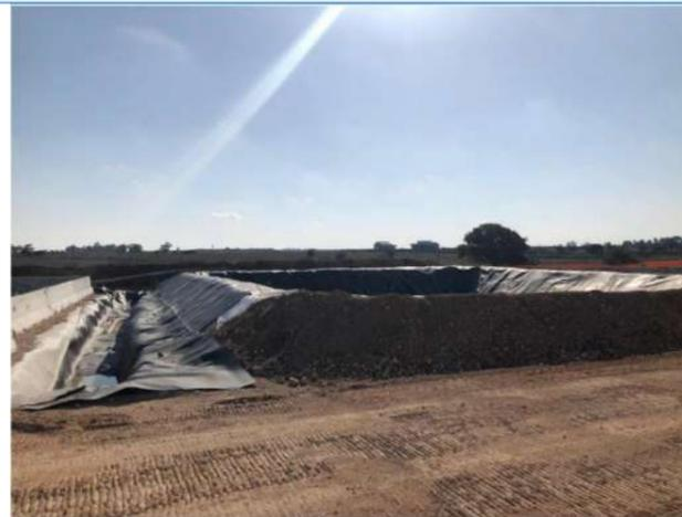
Vasca raccolta fanghi impermeabilizzata con geomembrana in HDPE
