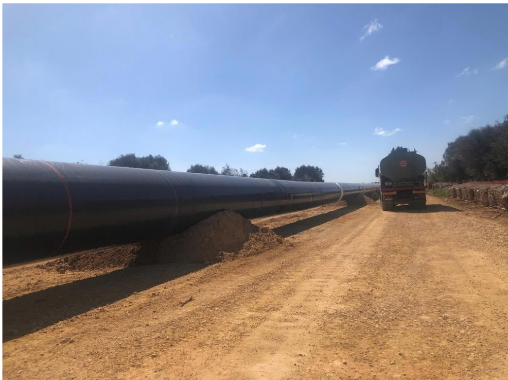
Fig. 1 – passaggio dell'autobotte per operazioni di bagnatura
