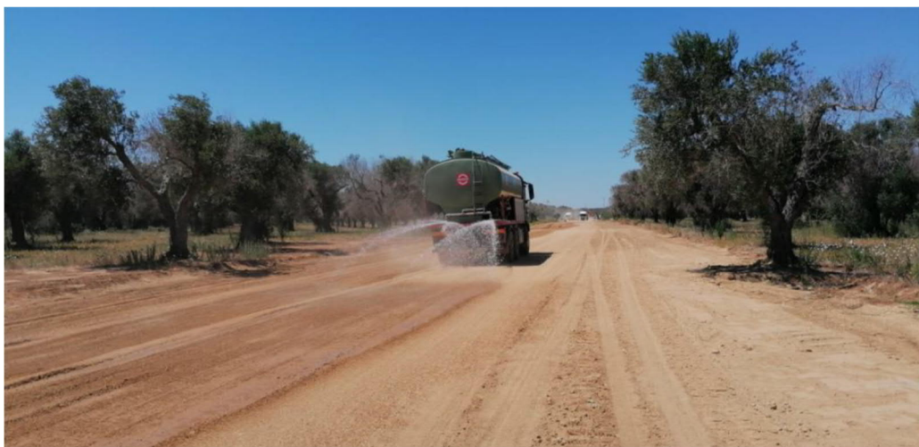
Fig. 1 - bagnatura pista mediante autobotte munita di ugelli
