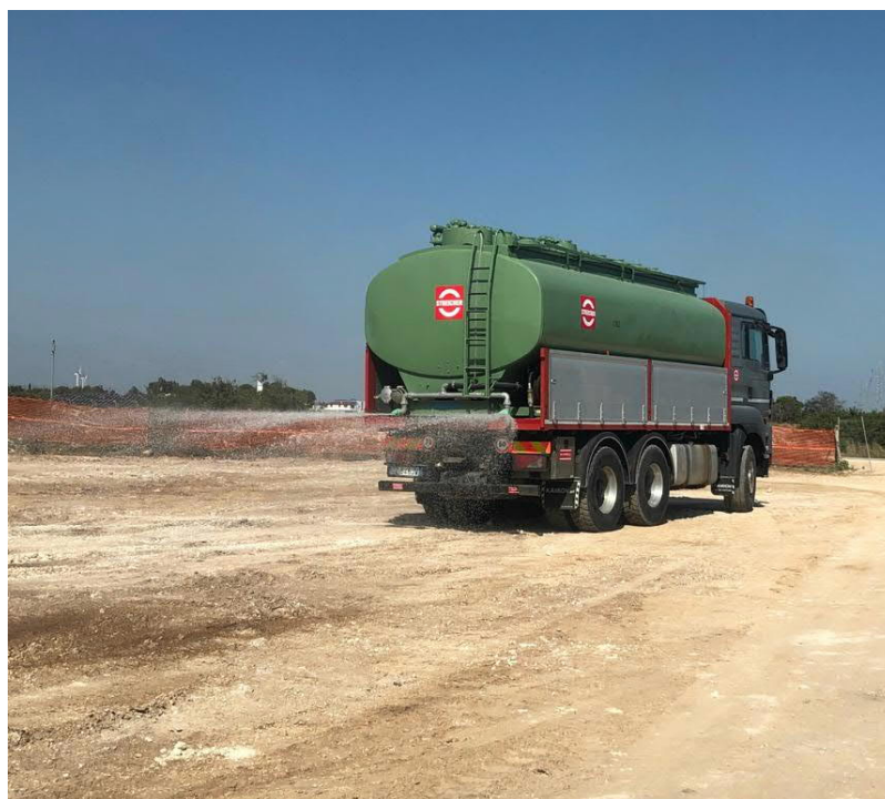
Fig. 1.d – operazioni di bagnatura dell'area di cantiere
