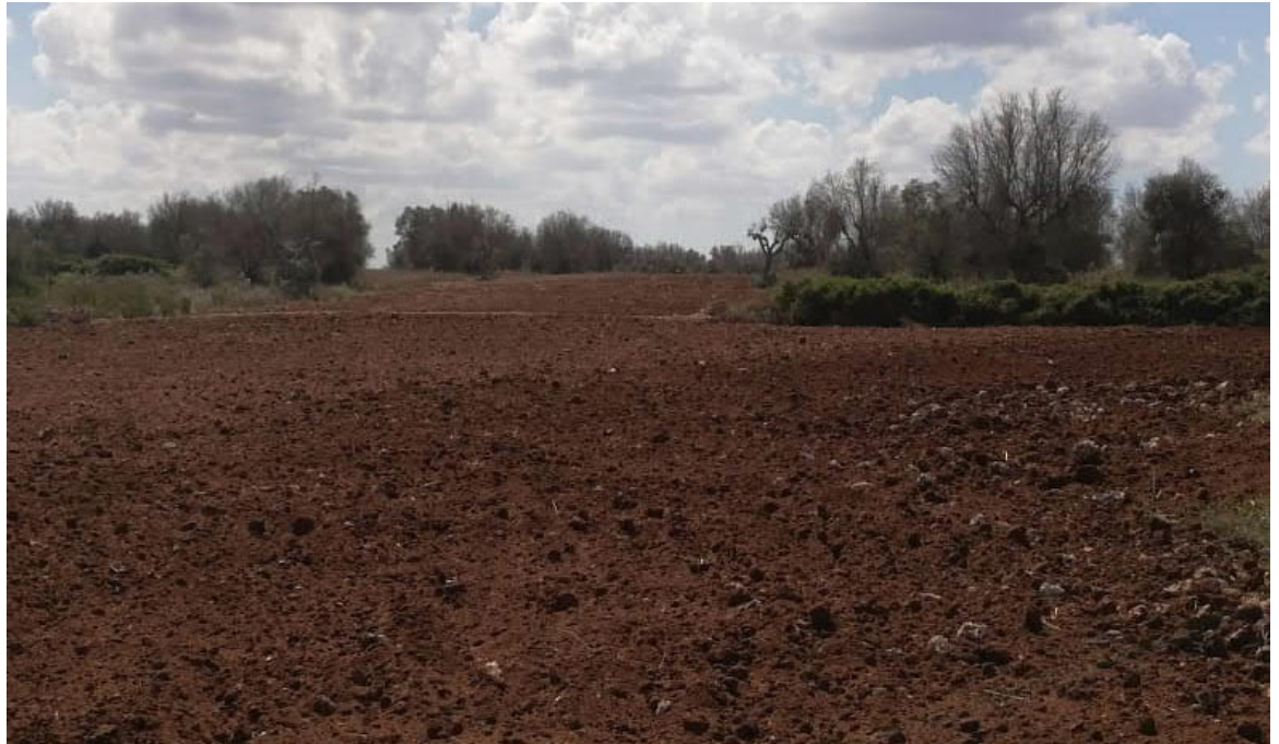
Fig. 4.a - pista di lavoro con ripristino morfologico
