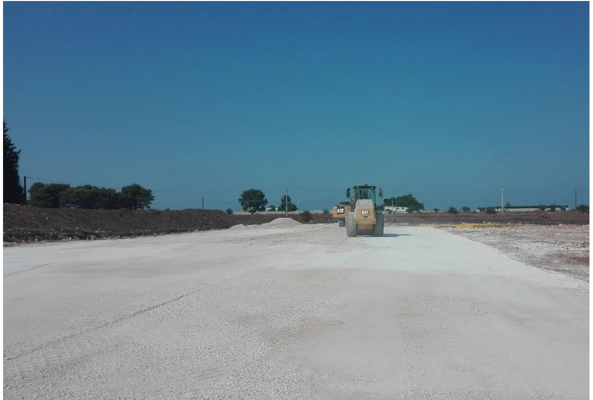
Fig. 1.a – allestimento dell'area di cantiere - Microtunnel Erchie Grande
