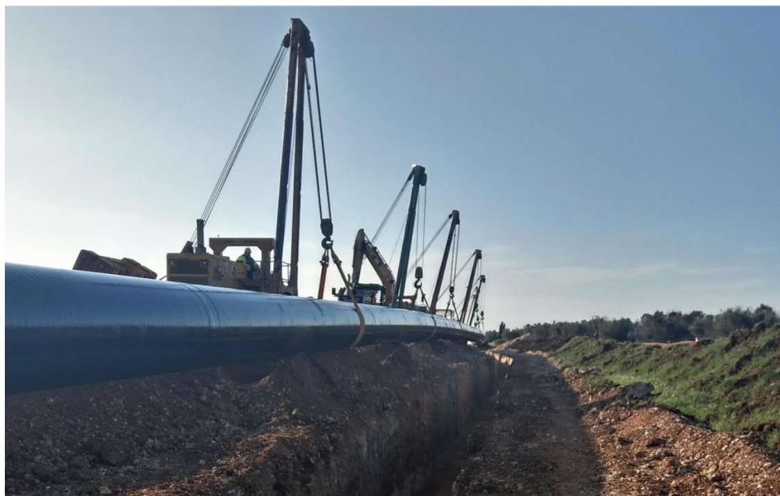
Fig. 3.a – posa della tubazione
