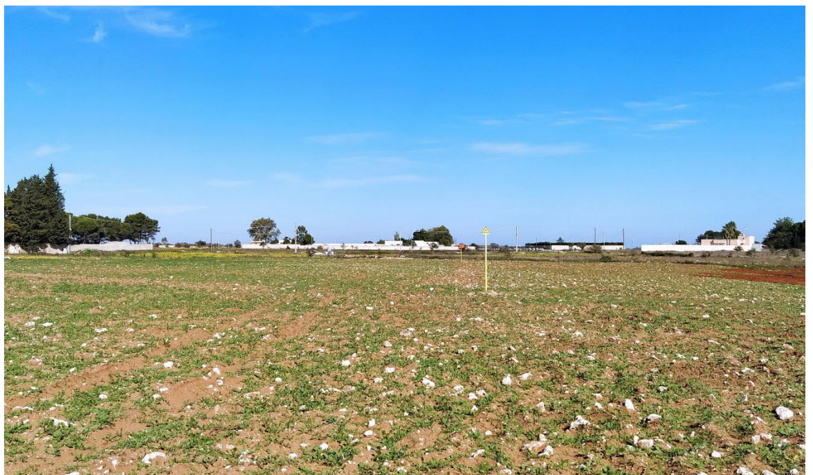
Fig. 2.a – Ripristino morfologico con riposizionamento dell'humus accantonato - Microtunnel Erchie Grande
