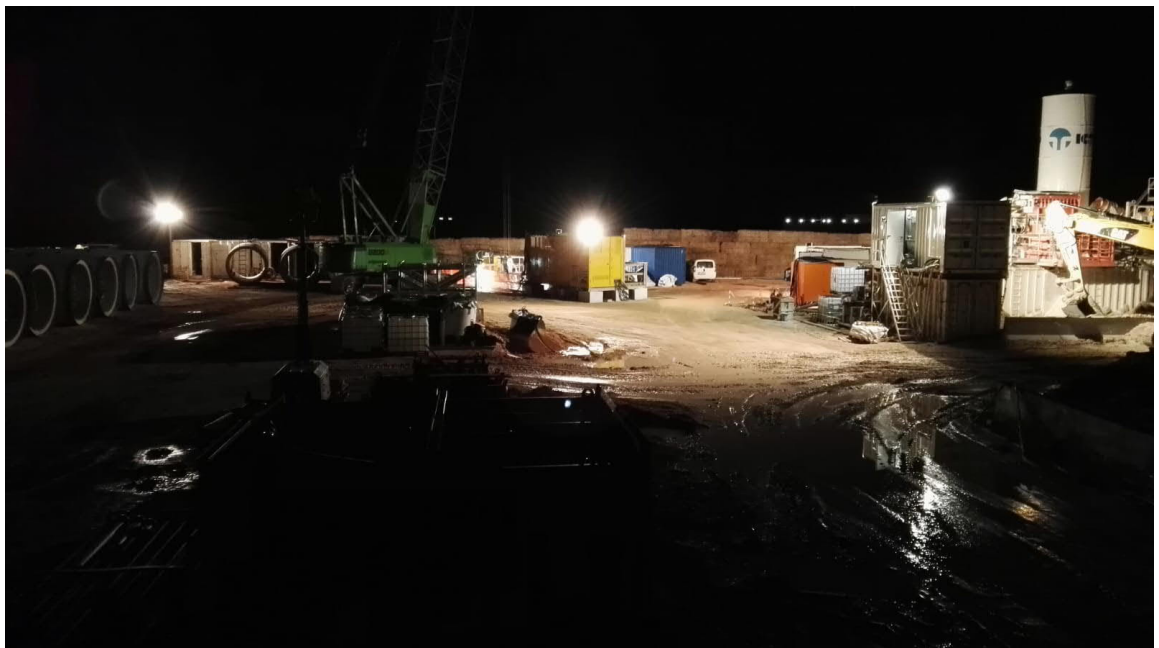
Fig. 1.e – illuminazione dell'area presso il microtunnel "Earchie grande"
