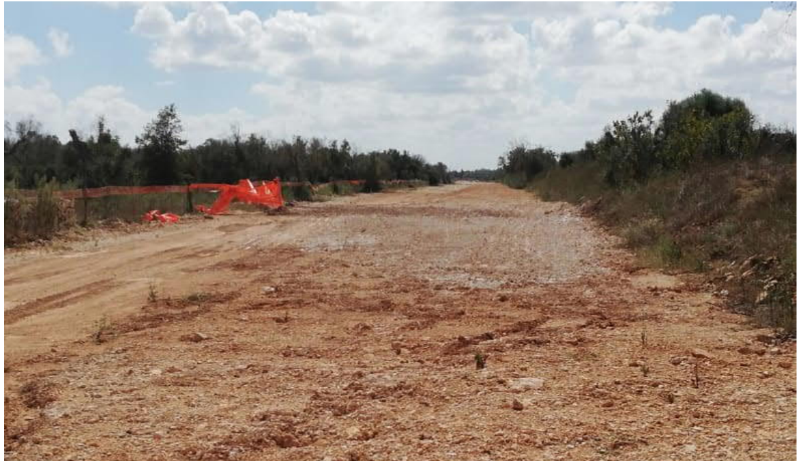
Fig. 5.a – rinterro della condotta nel tratto interessato
