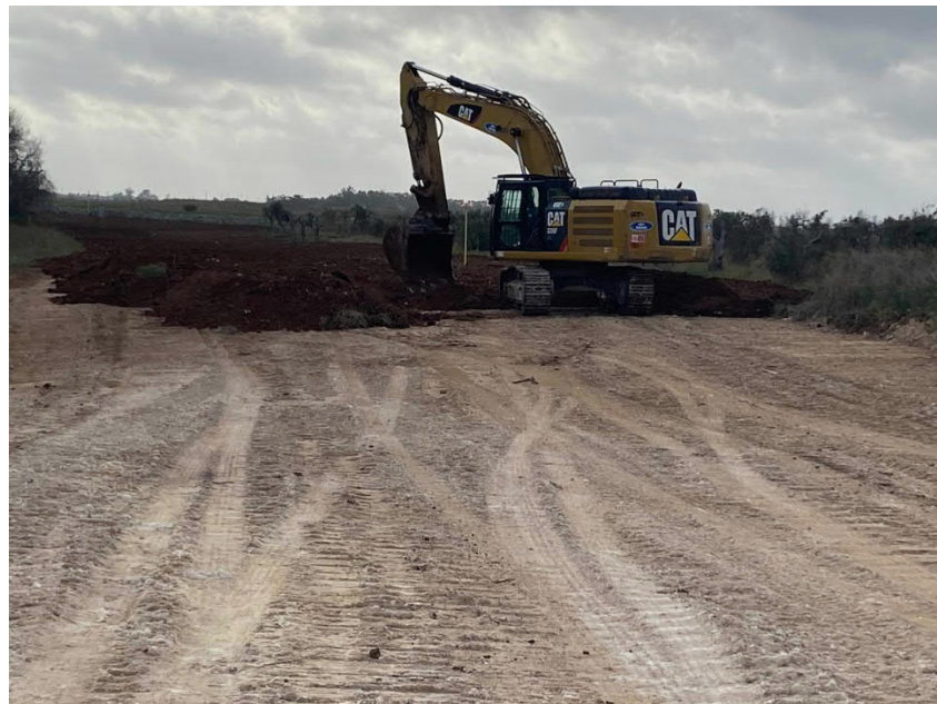
Fig. 2 – Posa dello strato superficiale con esecuzione del ripristino morfologico
