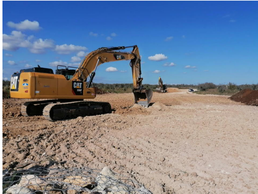
Fig. 1 – Preparazione dello strato di “contatto”
