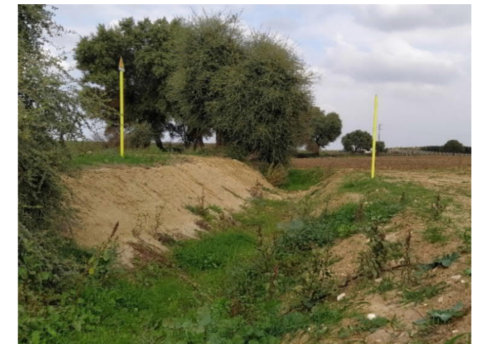
Riprofilatura dell'alveo e ripristino dei luoghi
