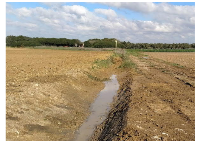
Riprofilatura dell'alveo e ripristino dei luoghi
