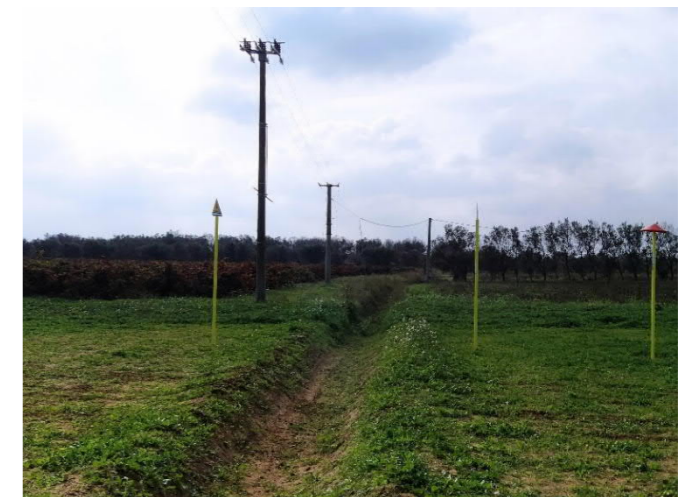
Riprofilatura dell'alveo e ripristino dei luoghi
