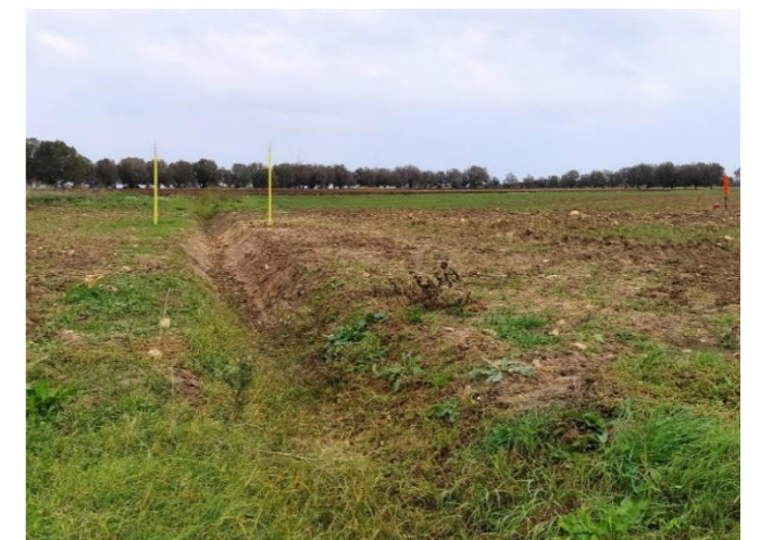
Riprofilatura dell'alveo e ripristino dei luoghi
