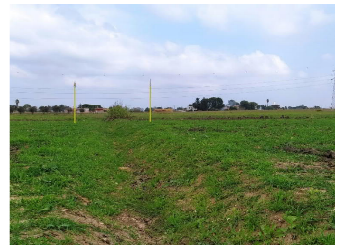
Riprofilatura dell'alveo e ripristino dei luoghi
