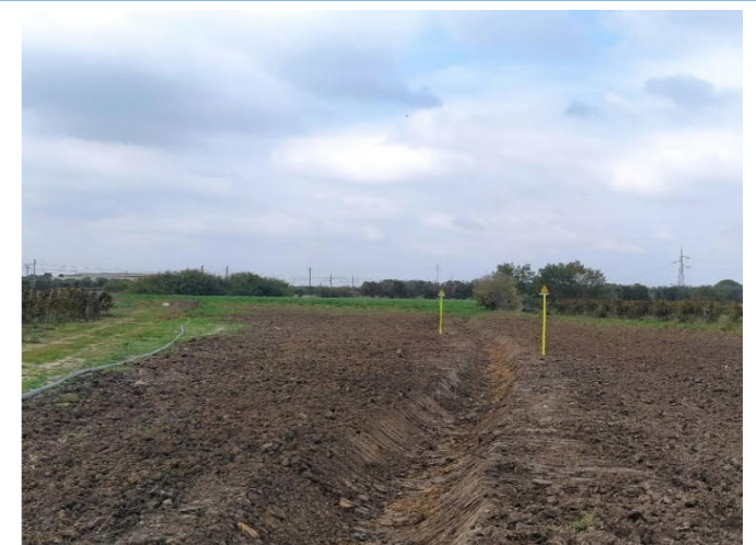
Riprofilatura dell'alveo e ripristino dei luoghi
