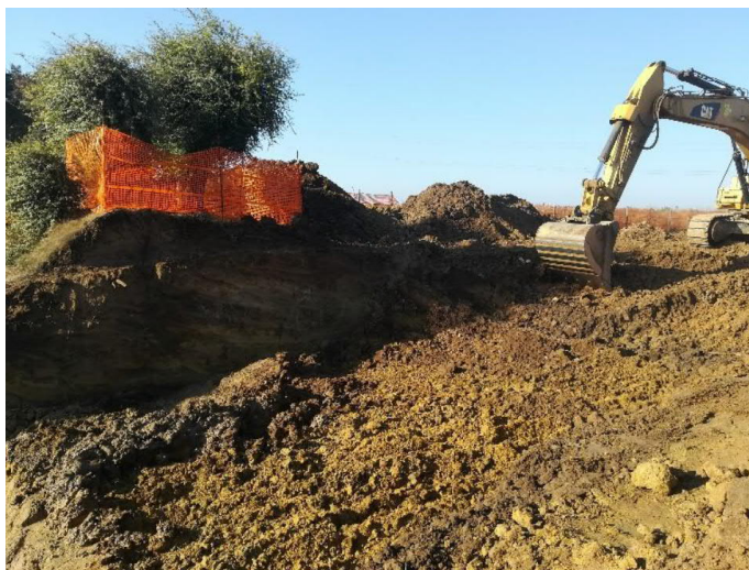
Fig. 2 – esemplare di Quercus suber ricadente all'interno della pista lavori autorizzata e salvaguardato con apposita recinzione.
