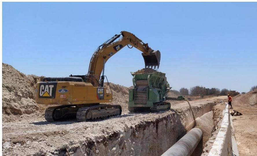
Fig. 1.a – Prerinterro con l'ausilio di vibrovaglio
