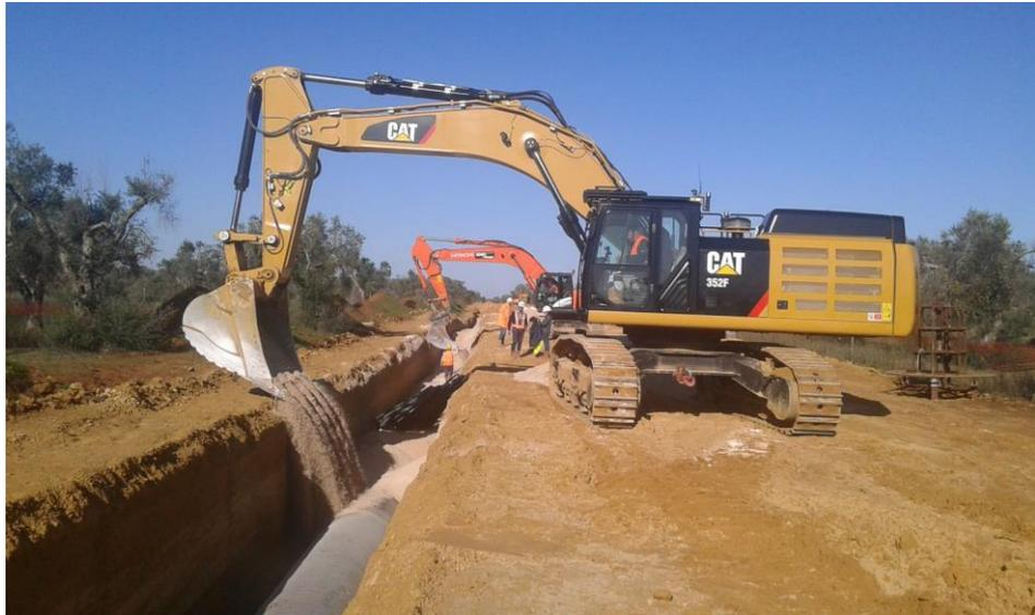
Fig. 2 – Operazioni di prerinterro con materiale precedentemente vagliato
