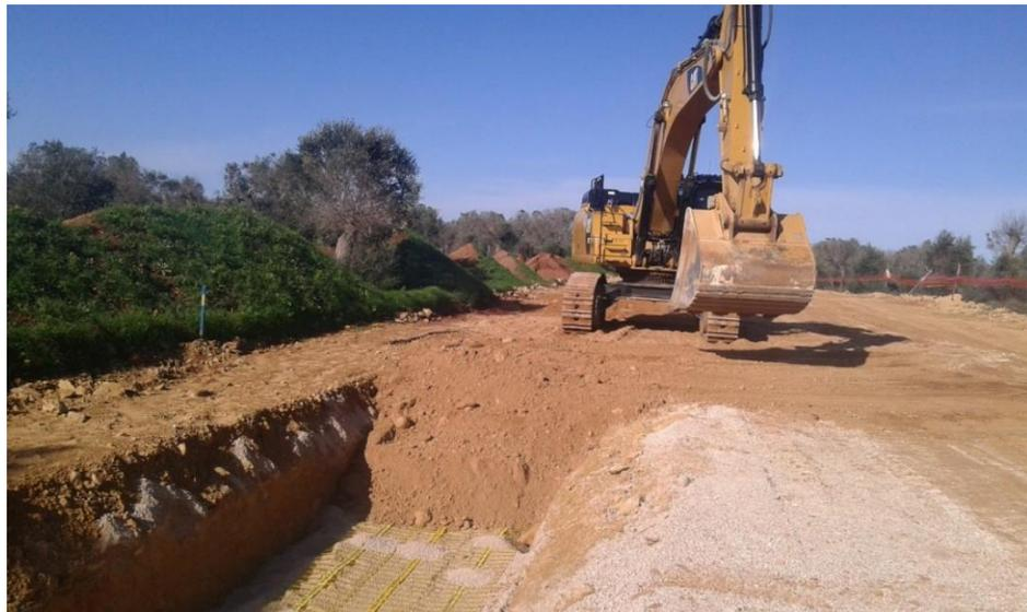
Fig. 3 – Costipazione del terreno dopo il rinterro della trincea
