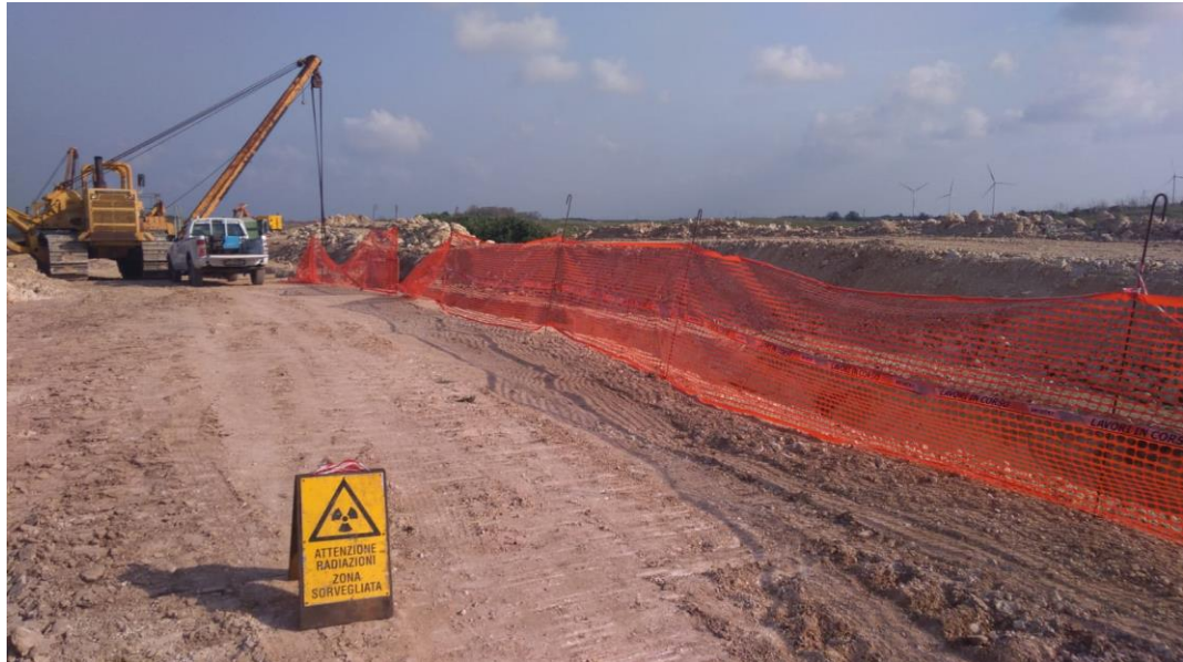
fig. 1.f – Segnalazione indicante il tipo di zona durante l'esecuzione del controllo delle saldature
