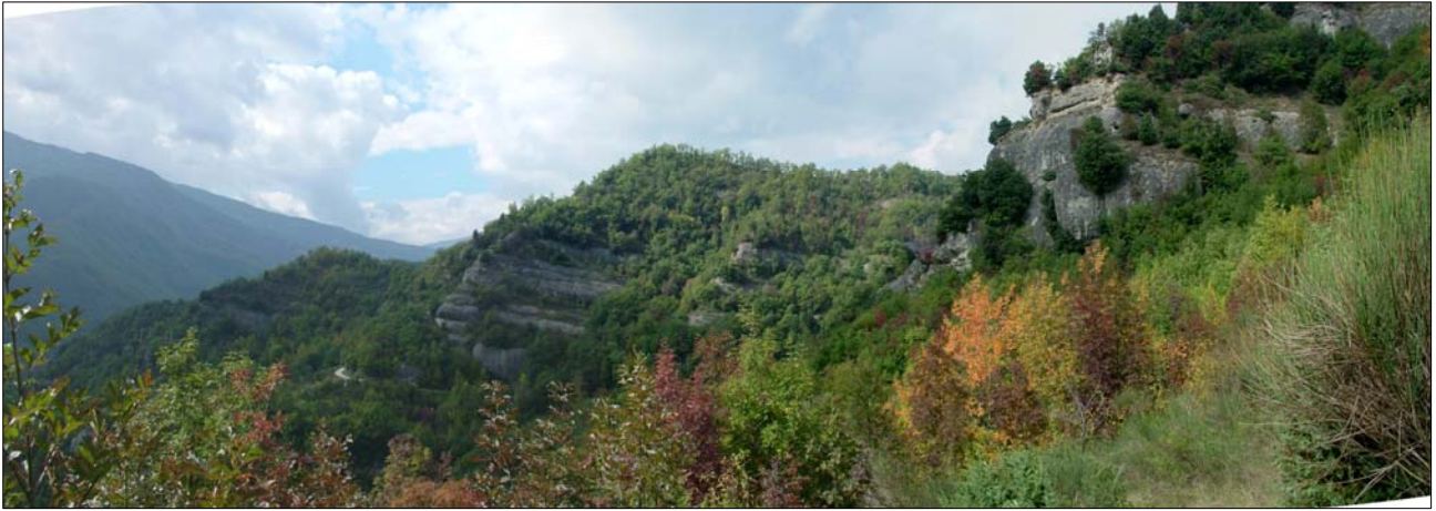
Foto 11 Galleria vista Est-Ovest. Località Morrice
