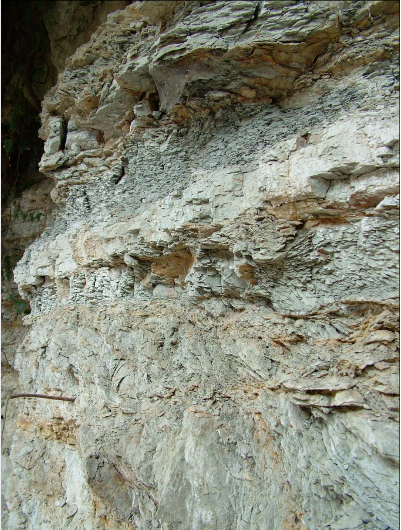
Foto 24 Dettaglio Contatto membro calcareo della Scaglia cinerea al passaggio con il Bisciaro Affioramento vicino alle terme di Acquasanta Terme
