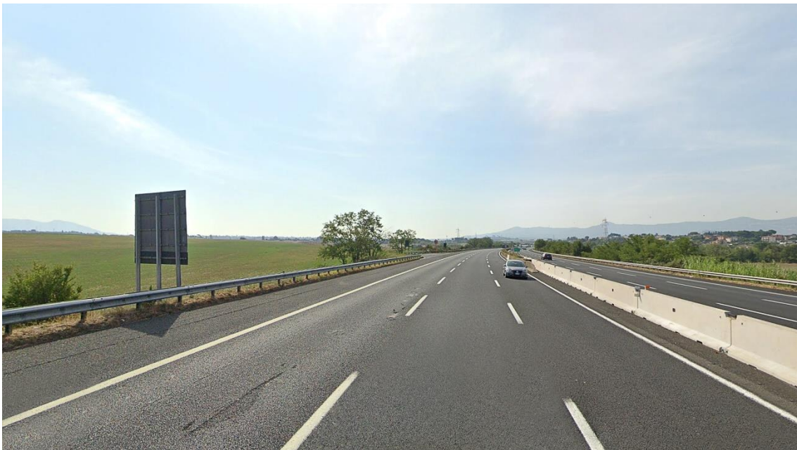
Figura 6-3 Punto di vista F01 condizioni percettive ante operam
