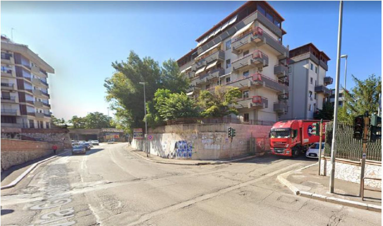
Figura 25 - Immissione di Via Nicola su Viale Fortore
