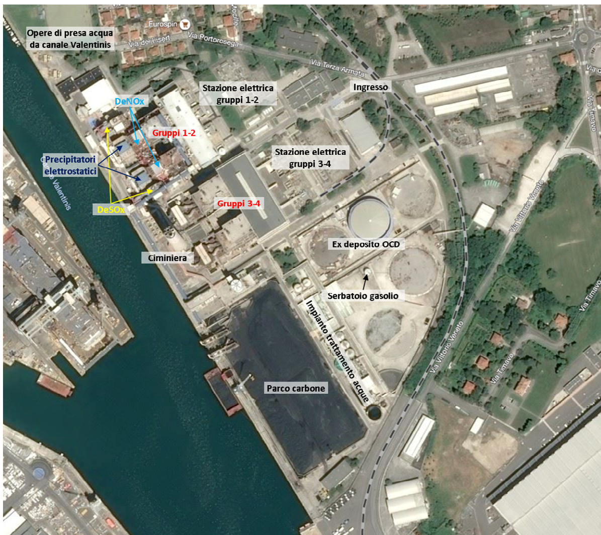
Figura 1 – Immagine aerea della Centrale di Monfalcone
