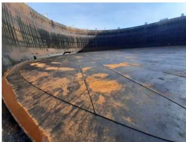
Foto n. 50 – Area decommissioning - Vista serbatoio K19-2 bonificato ma non ancora gas free
