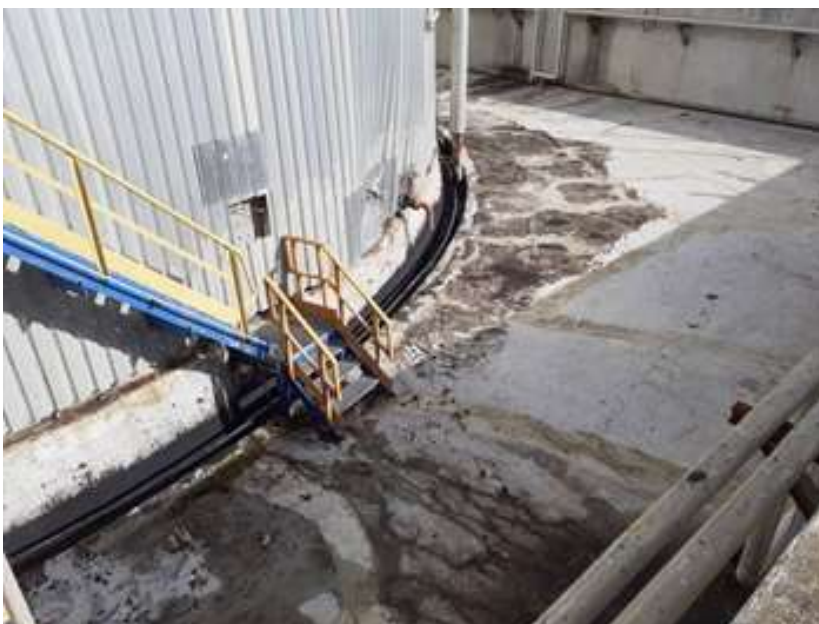
Foto n. 35 – Serbatoi OCD: particolare bacino di contenimento
