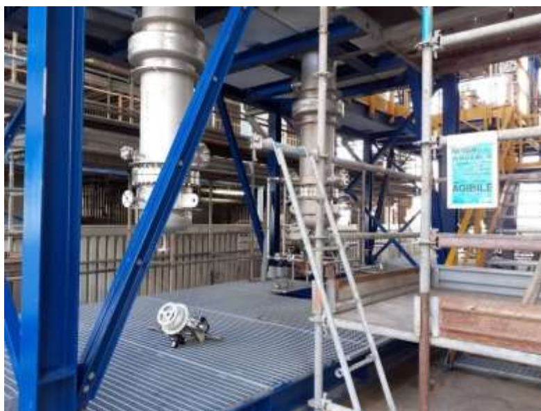
Foto n. 19 – EL 34 800 GR.4: impianto di evaporizzazione dell'ammoniaca in fase di realizzazione
