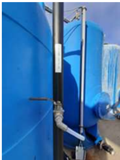
Foto n. 32 – impianto TAF: particolare rubinetto di campionamento
