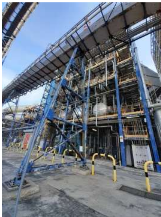
Foto n. 21 – GR.4: Impianto strippaggio NH3 area 14
