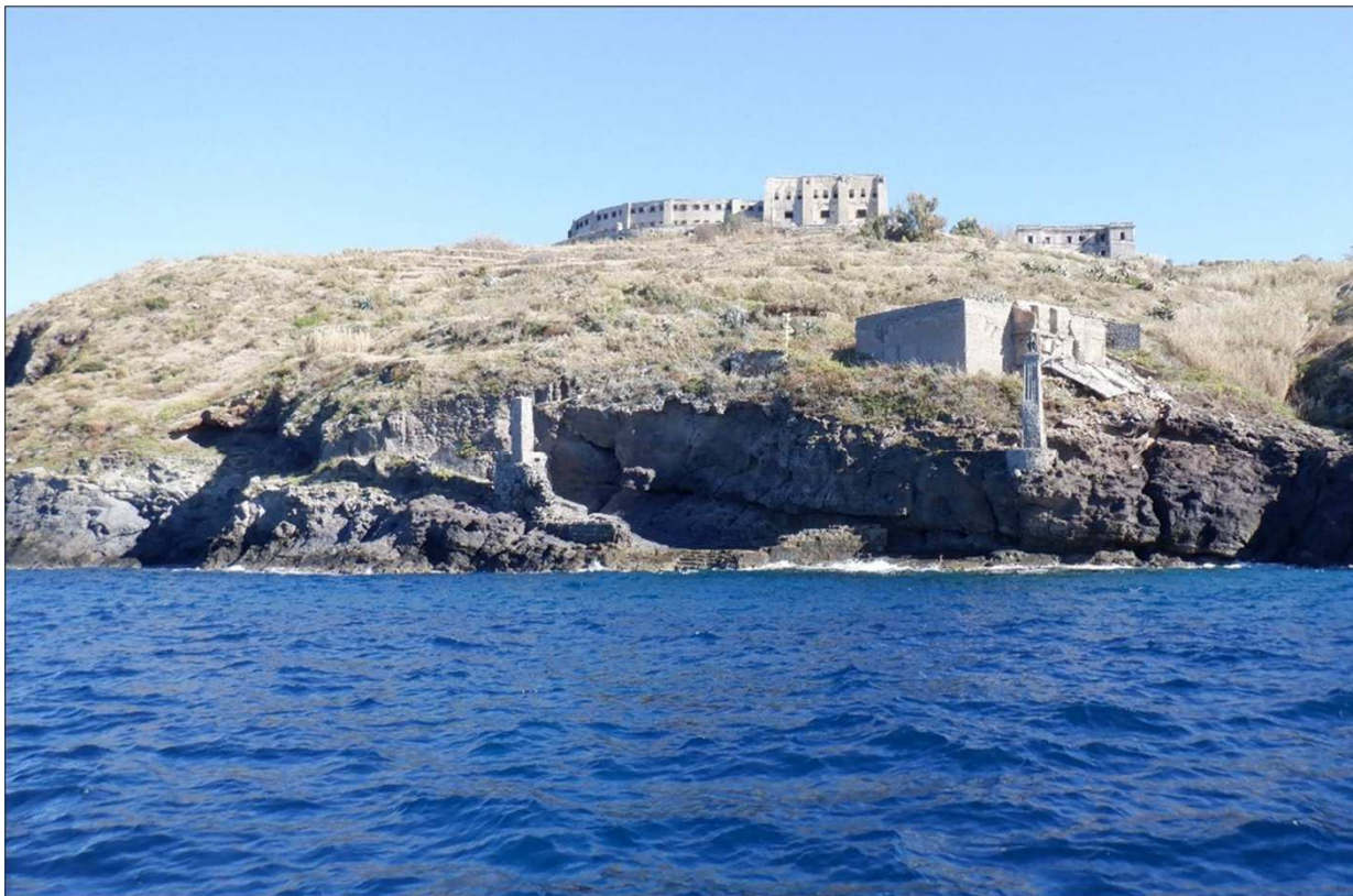
Figura 32. Vista da mare, mattina, condizione ante operam
