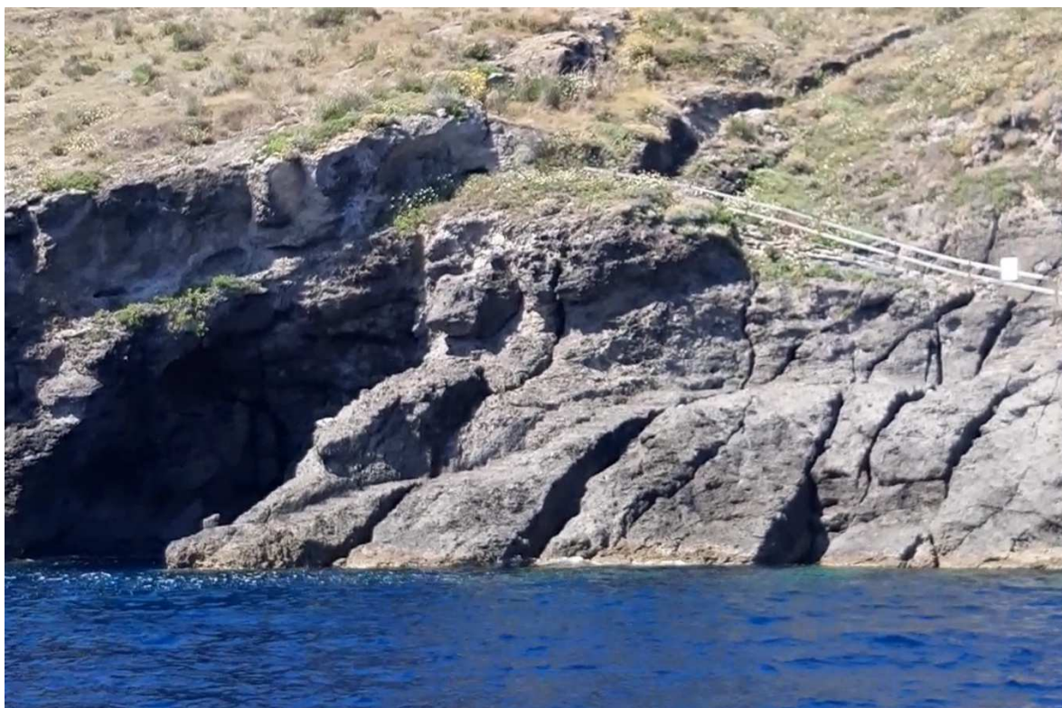
Figura 47. Vista da mare, condizione ante operam
