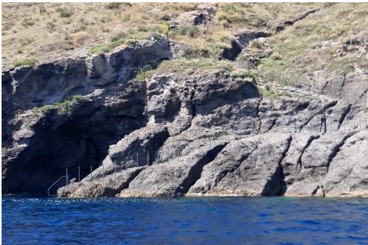
Figura 48. Vista da mare, condizione post operam
