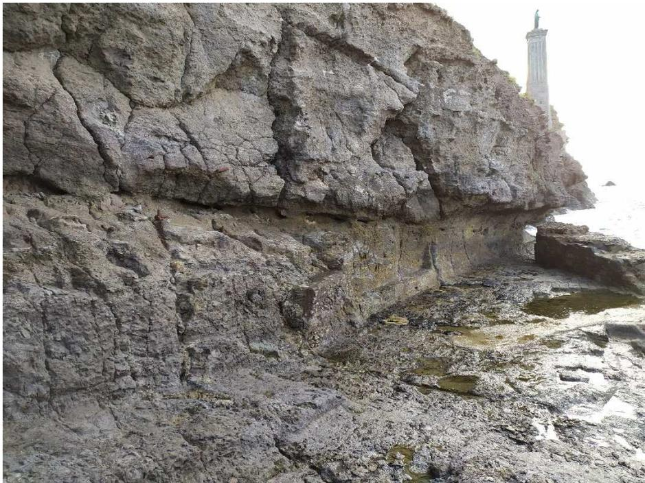
**Figura 4. Intervento 1, stato di fatto: Cavità antropica da chiudere per sottomurazione e falesia fessurata da stabilizzare tramite chiodature**
