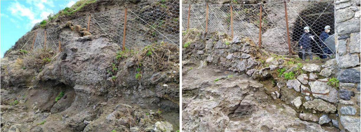
**Figura 8. Intervento 2: Muro e roccia sottostanti il percorso Marinella, con evidenza di dissesti locali**
