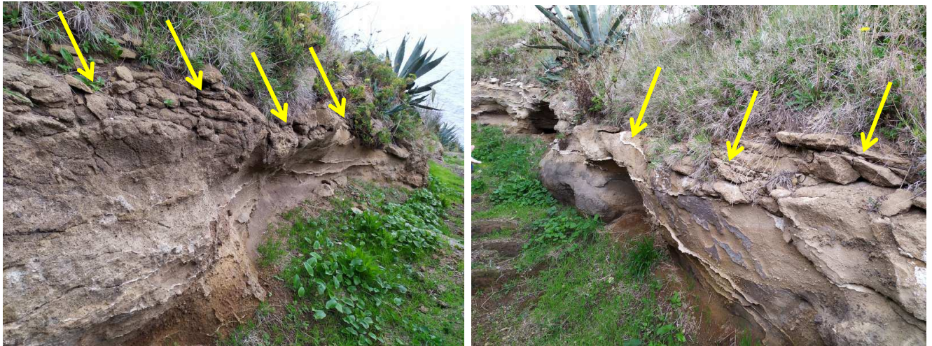
Foto 6: Tratto di sentiero scavato nella pietra naturale sul quale sono previste manutenzione ordinaria + riprofilatura delle porzioni sommitali – INTERVENTO 3.
