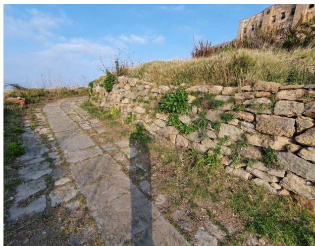
Foto 11: Esempio di ricorsi ben eseguiti con blocchi parallelepipedi con molti punti di contatto
