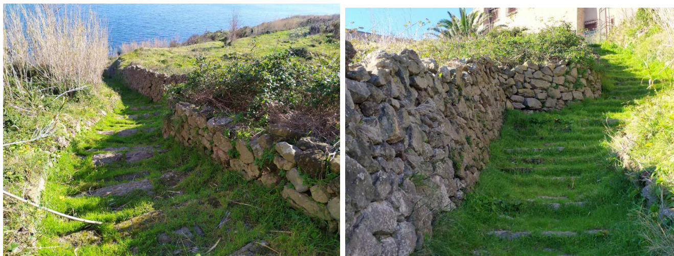
Foto 8: Muri a secco lato sud
