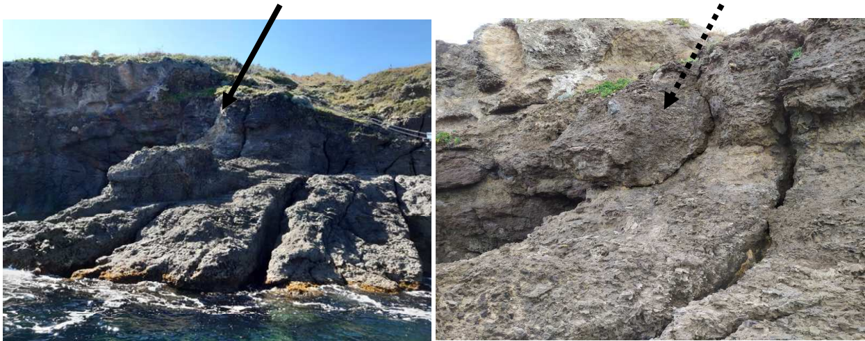
Foto 2: Indicazione della zona a terra dopo l'intervento di disaggio del cuneo (freccia nera) e prima dell'intervento (freccia nera tratteggiata)
