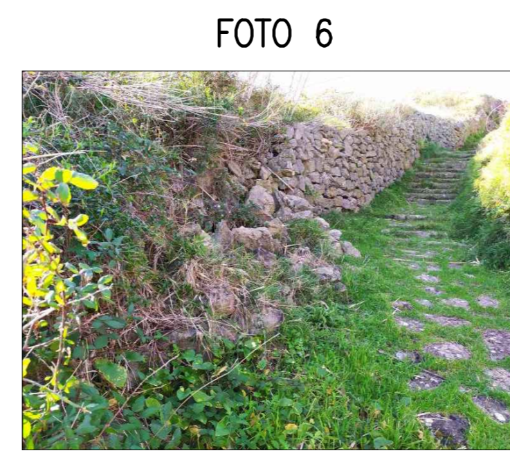
Intervento 4 - tipo C: Smantaggio e ricostruzione del muro
