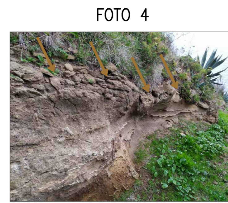
Intervento 3: Manutenzione ordinaria delle scarpate in roccia e riprofilatura sommitale
