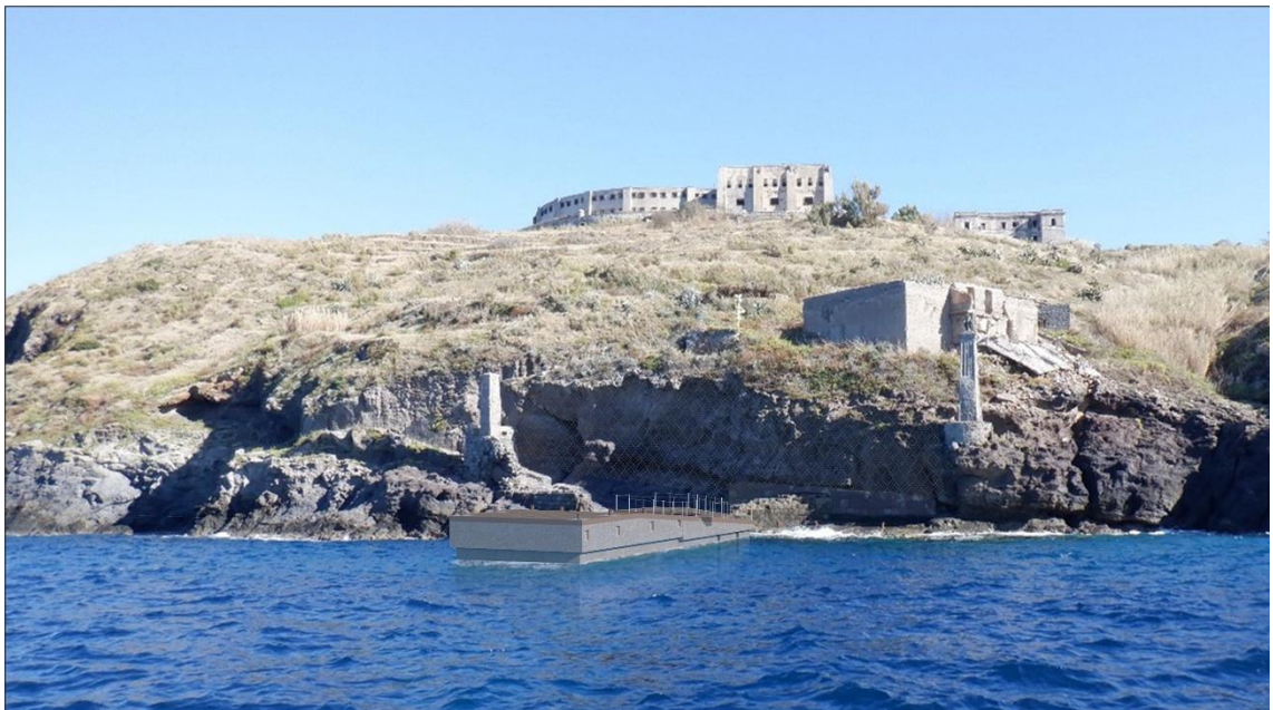
Figura 35 - Vista dal mare dell'area di approdo – post operam
