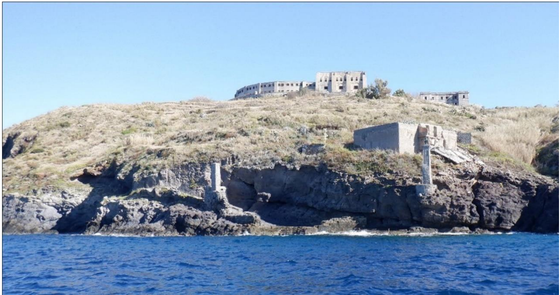
Figura 34 - Vista dal mare dell'area di approdo – ante operam
