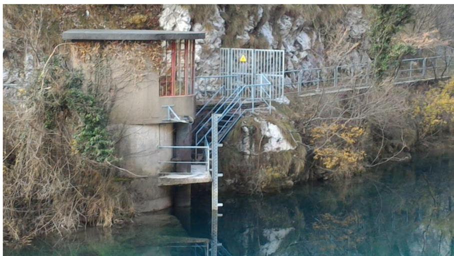
**Figura 6** – Cabina di manovra scarico di mezzofondo
