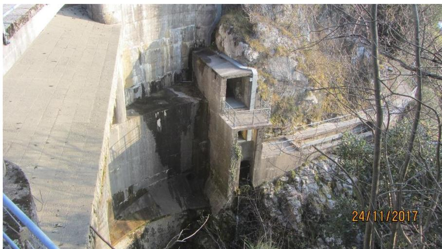
**Figura 9** – Restituzione e locale superiore scarico di fondo
