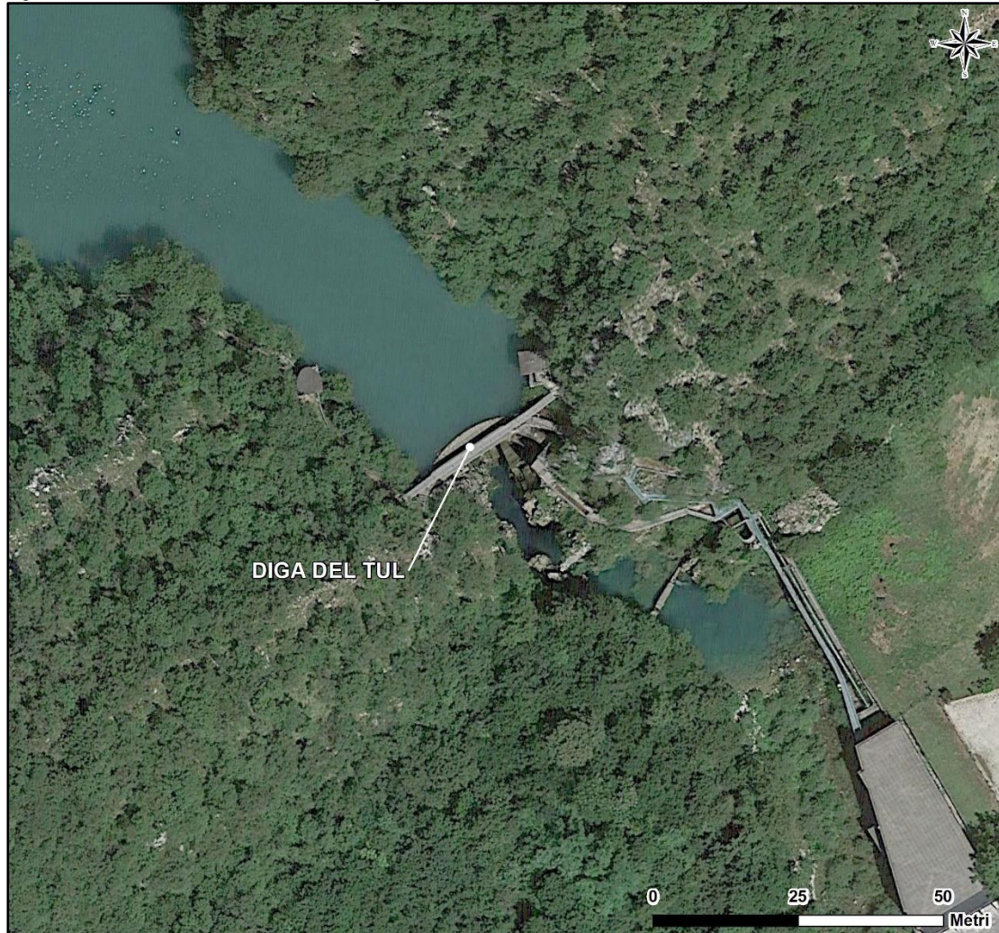
Figura 3.1a Localizzazione della Diga del Tul
