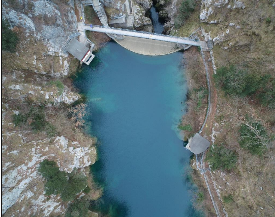
Figura 4.1.8g Percorso di accesso alla cabina di manovra dello scarico di mezzofondo in riva destra
