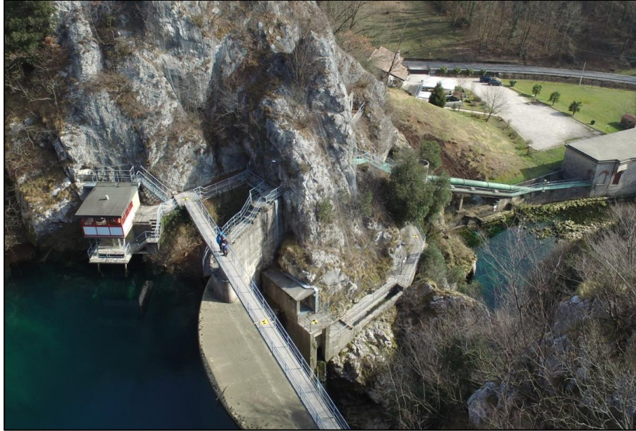
Figura 4.1.8e Percorso di accesso alla Diga e alla cabina di manovra della derivazione elettrica
