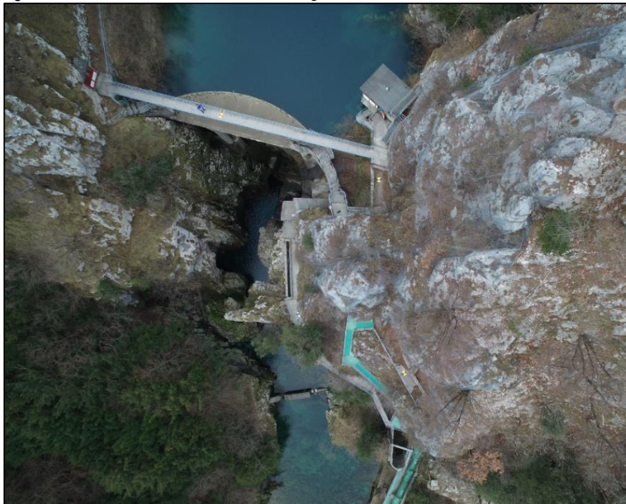
Figura 4.1.8f Percorso di accesso alla Diga e alla cabina di manovra della derivazione elettrica dall'alto
