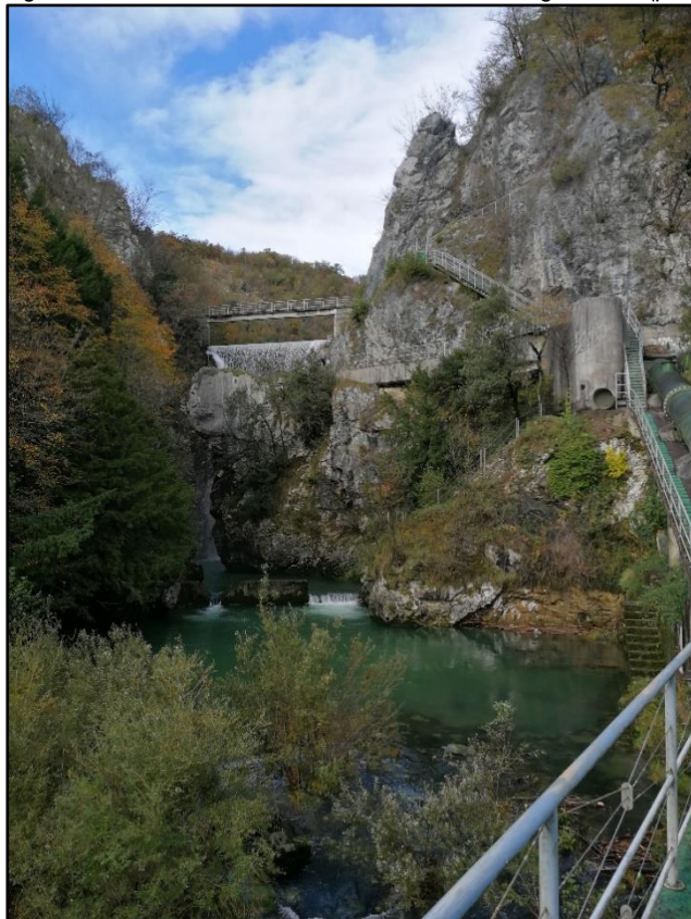
Figura 4.1.4.2.2d Vista dello sbarramento della Diga del Tul (presa fotografica da camminamento)
