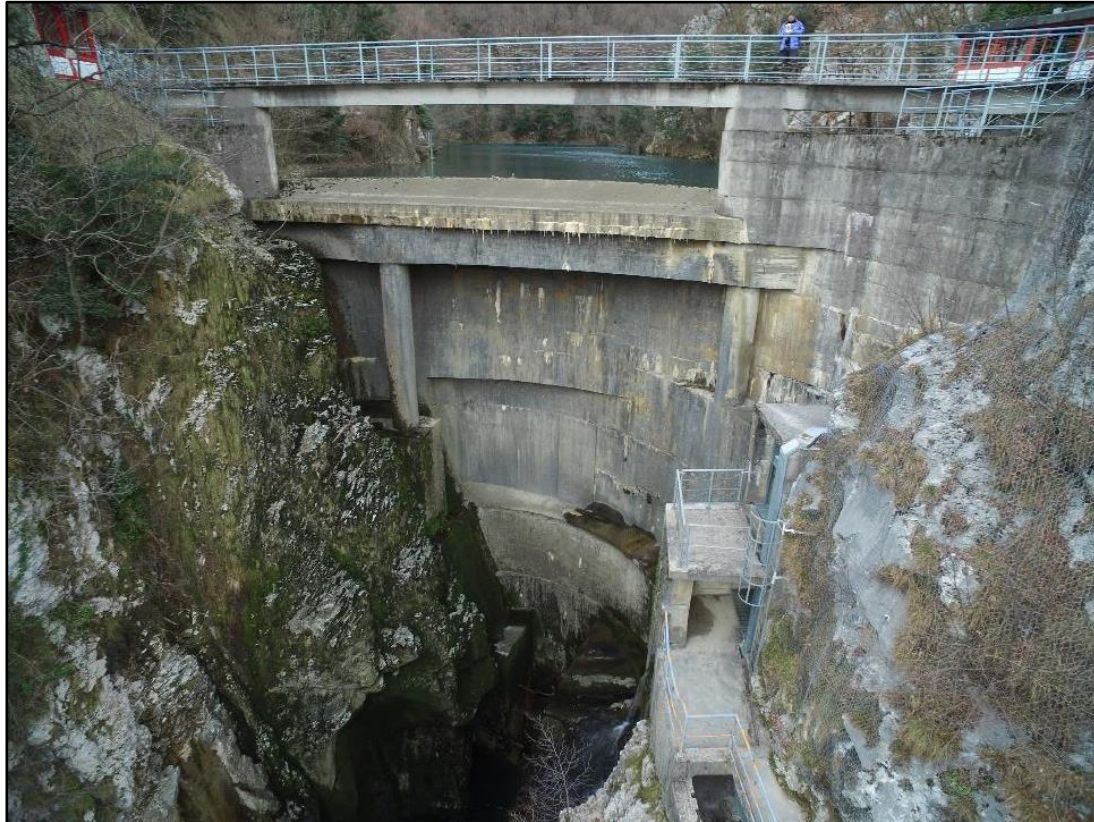
Figura 3.1b Vista da valle della Diga del Tui
