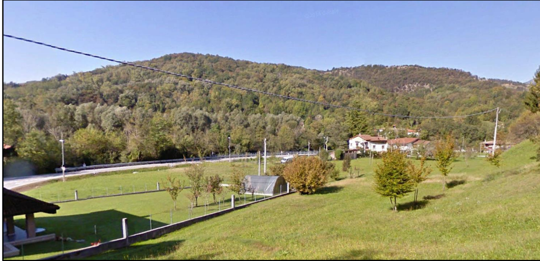
Figura 2.3.2d Fondovalle del Torrente Cosa a sud dello sbarramento
