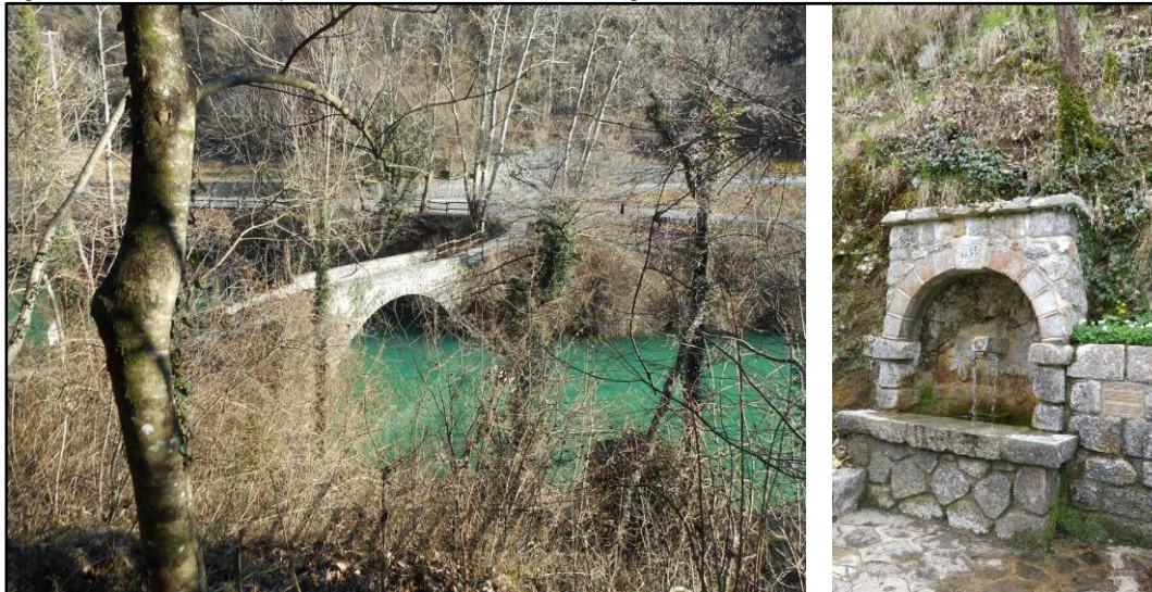
Figura 2.3.2h Ponte pedonale sul Torrente Cosa e Sorgente del Tof
