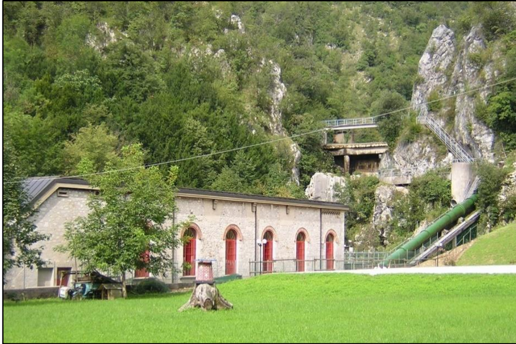
Figura 2.3.2i L'edificio della Centrale idroelettrica e, sullo sfondo, lo sbarramento
