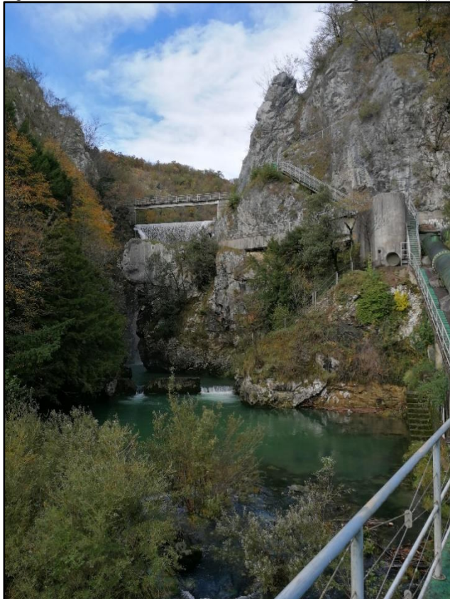
Figura 4.2.1.2d Vista dello sbarramento della Diga del Tul (presa fotografica da camminamento)
