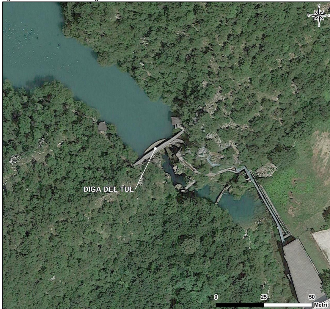
Figura 3a Localizzazione della Diga del Tul
