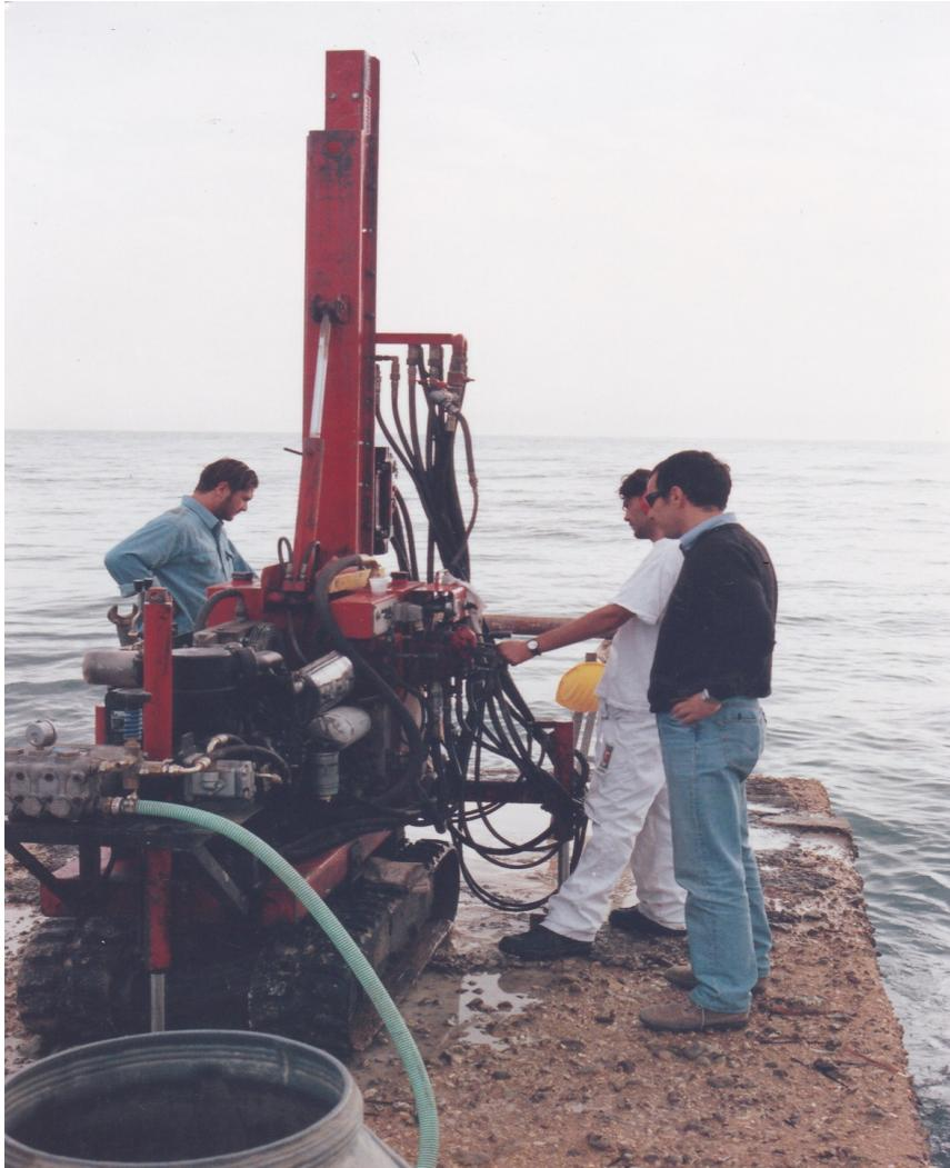
Foto 2: Esecuzione del sondaggio S1 sul molo nord
